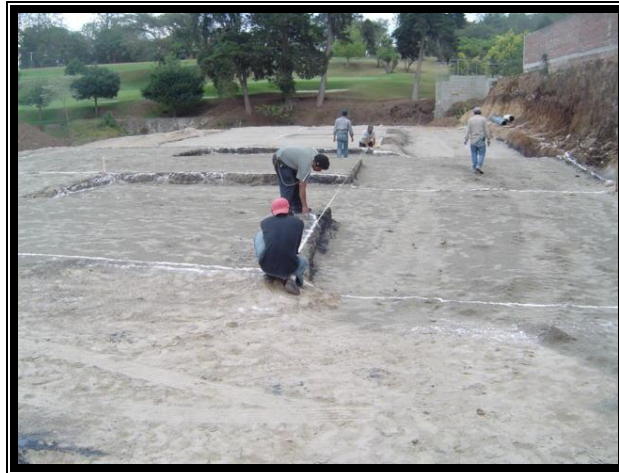
Figura No. 17 Medición de plataformas terminadas
