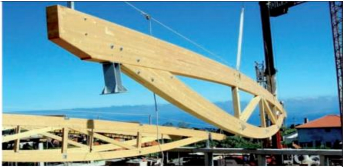
Ilustración 22 Viga de 26.50 metros de cubierta de piscina en Porto Moniz. Madeira. Portugal (2004)
