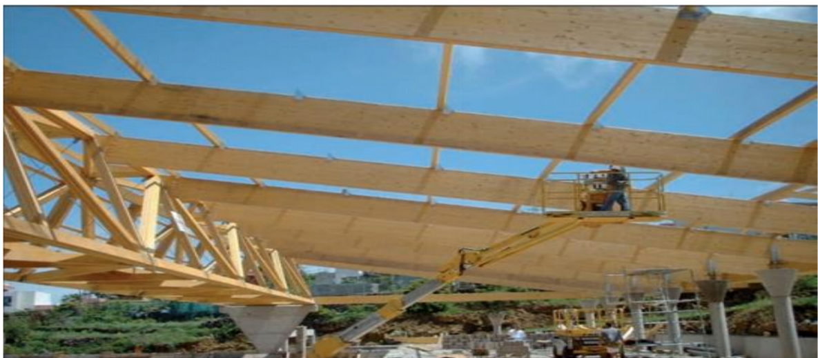
Ilustración 23 Cercha lucernario tridimensional de 42m, madera microlaminada. Kerto soportando vigas de madera laminada de 20m. Tenerife
