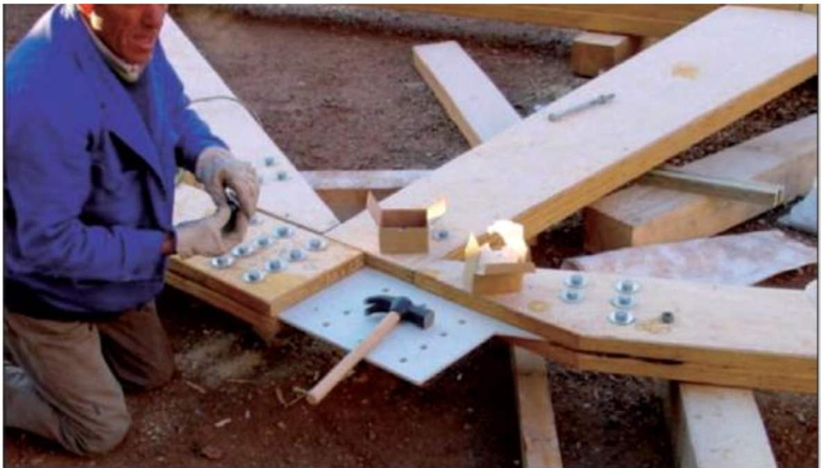
Ilustración 25 Conexión de placas de acero con pernos
