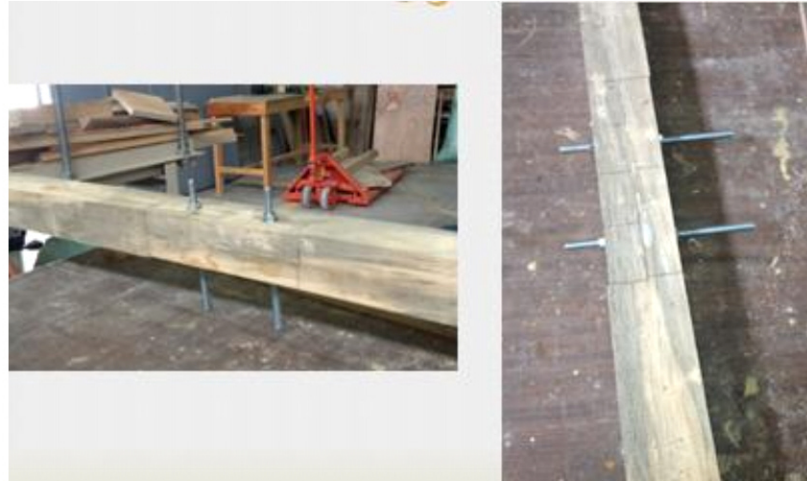
Ilustración 43 Viga unida con pernos
