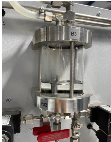
Figura 25. Fotografía del depósito de separación de fases del destilado en la torre de rectificación Gunt Hamburg CE600 durante el inicio de un ensayo mientras no se ha alcanzado el sobrenivel de reflujo en el Laboratorio de Operaciones Unitarias de la Universidad del Valle
