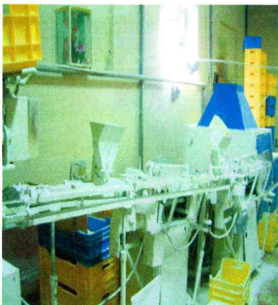
Fotografía No. 7 Vista general de formadora
