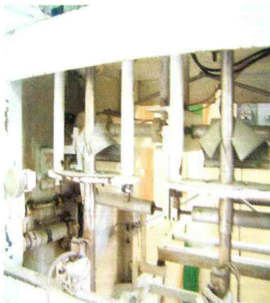
Fotografía No. 10 Secciones de empacadora que habrá que modificar
