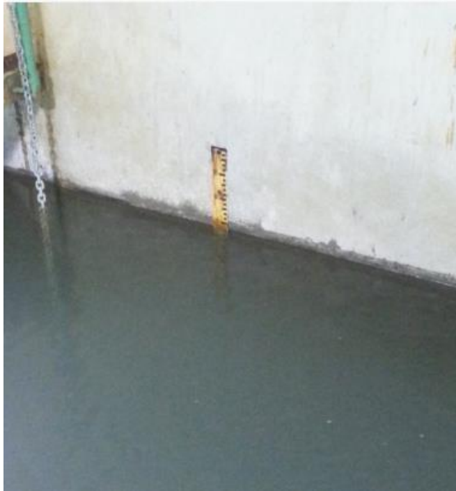
Figura No. 24. Medidor de nivel
