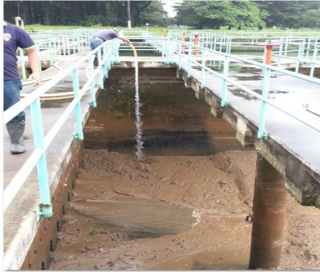
Figura No. 23. Lavado de lodo con agua potable
