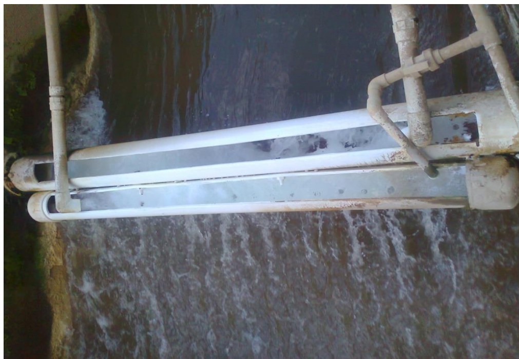
Figura No. 13. Oxidación de tuberías
