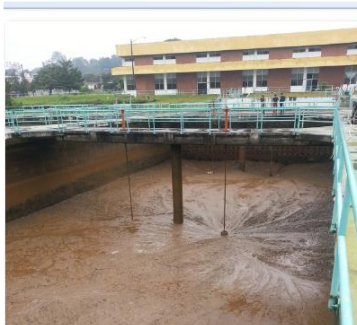
Figura No. 16. Tanques de lodos
