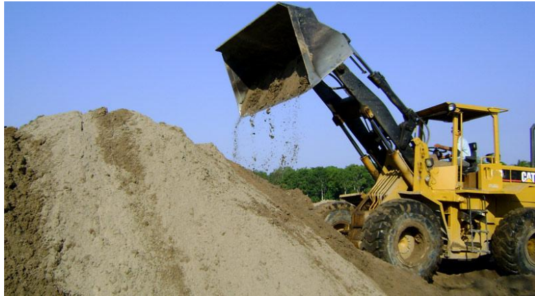
Ilustración No. 11: Apilamiento de arena de río.
