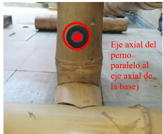
Figura 58. Vista frontal del pivote trasero. (Eje axial del perno paralelo al eje axial de la base).
