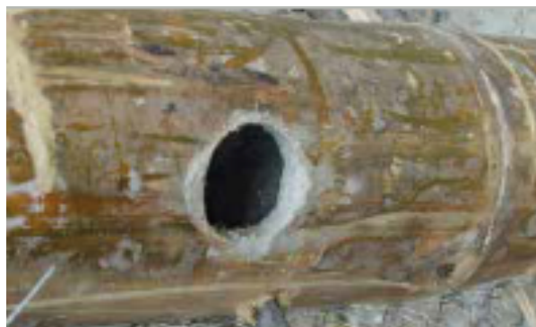
Figura 8. Relleno de mortero.
