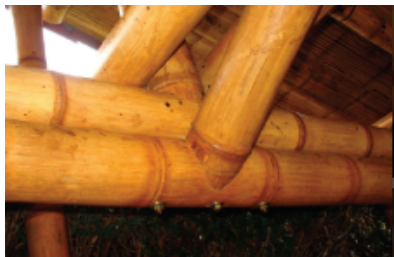
Figura 4. Unión de boca de pescado.
