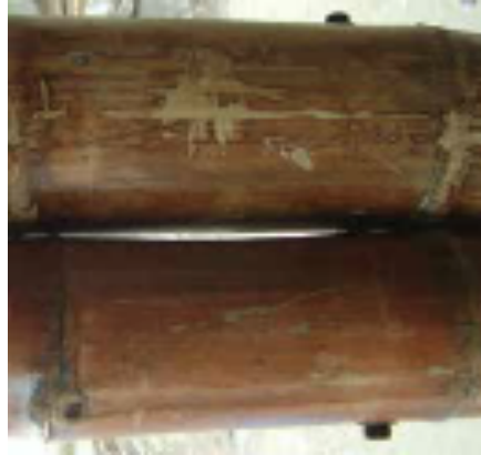
Figura 5. Perno pasante, fijando 2 o más culmos.
