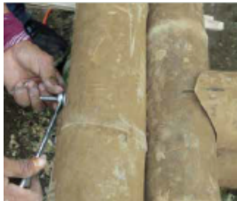
Figura 6. Instalación de perno tensor.
