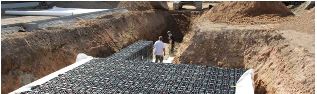
Figura 5. Ejemplo de depósitos de infiltración.
