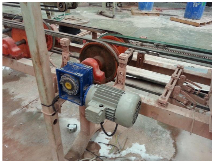
Imagen 14: Motor con caja reductora 30
