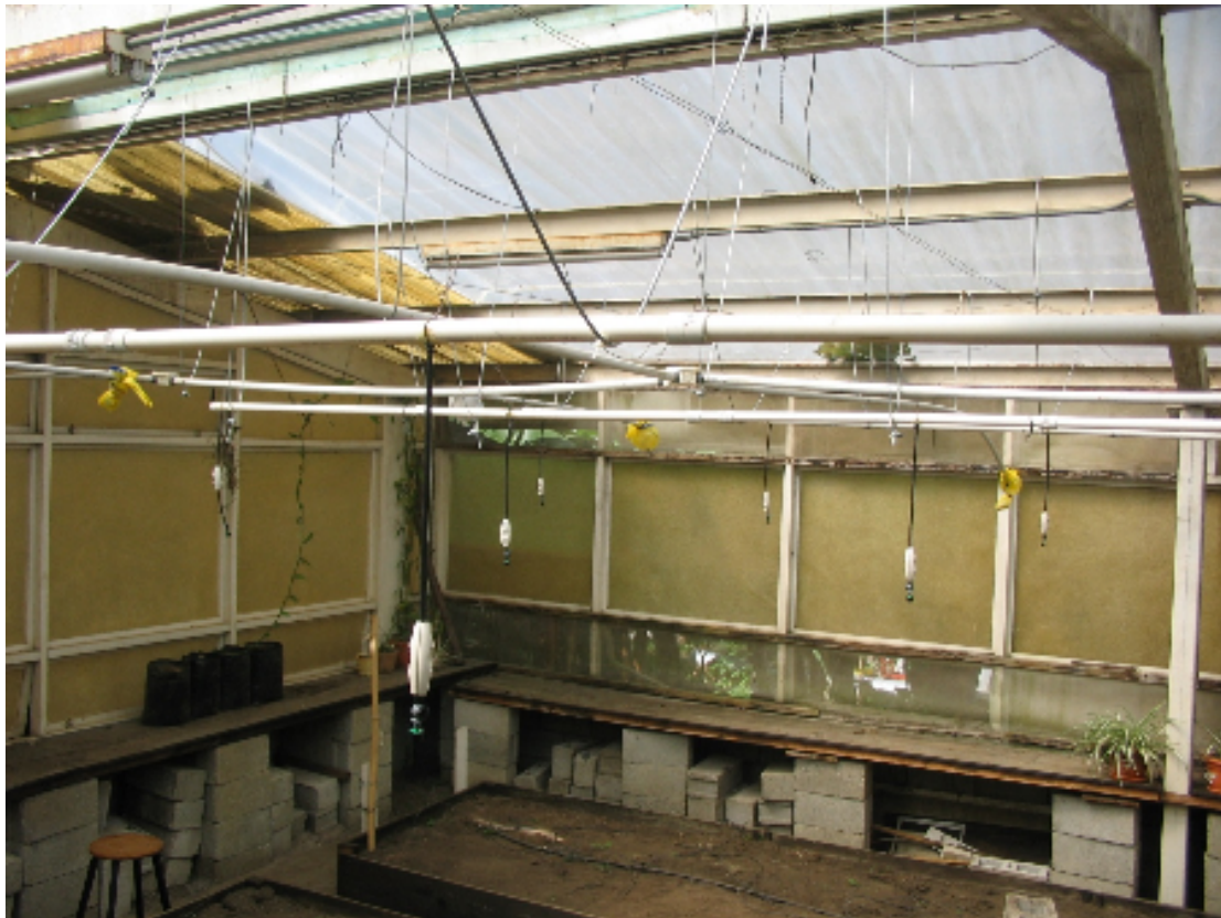
Figura No. 39: Vista lateral de las ramas auxiliares (macetas grandes) elevadas
