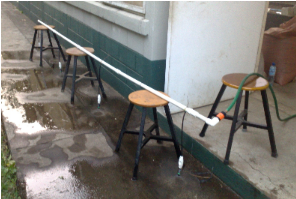
Figura No. 38: Prueba de fugas a una rama auxiliar
