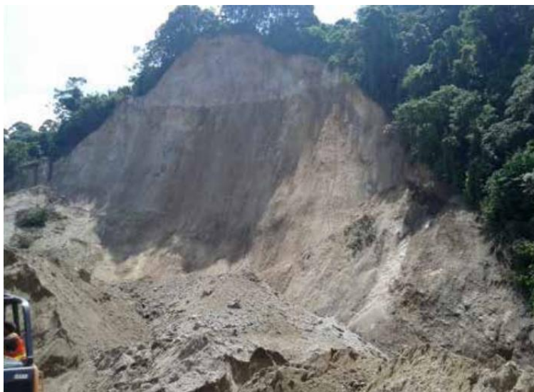
Figura 1 Deslizamiento de depósitos cuaternarios
