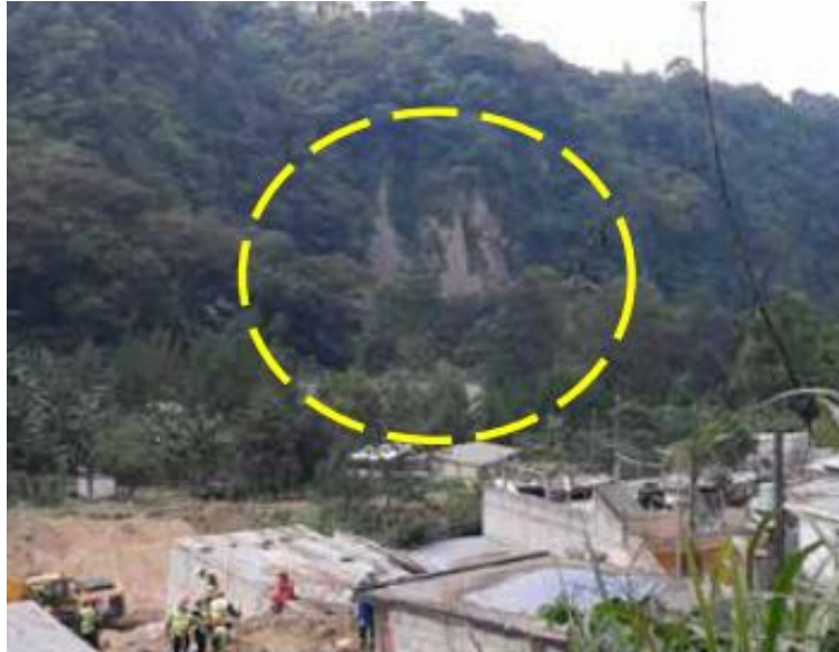
Figura 4 Desprendimiento de suelos antiguos del talud
