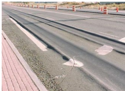
Figura 29: Huella de rodadura (Barrera, 2014)
