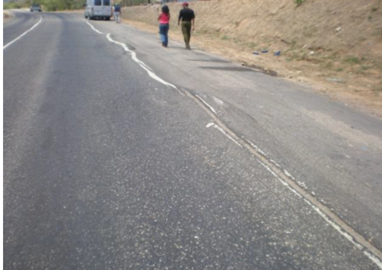
Figura 34: Desplazamiento de borde (Barrera, 2014)
