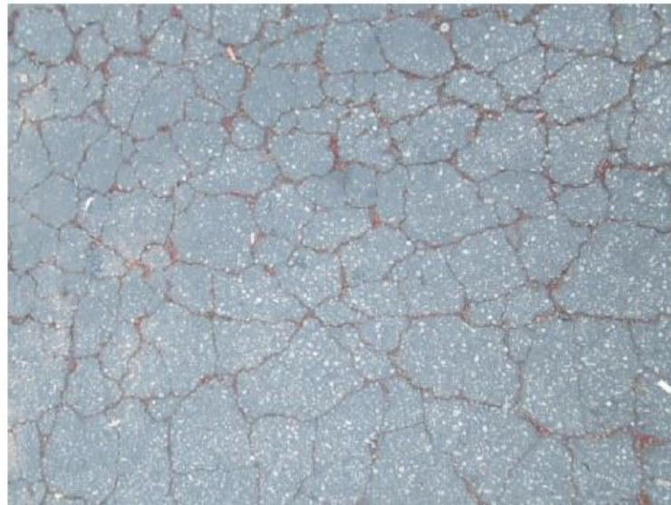
Figura 35: Fisura piel de cocodrilo (Hernández, 2015)
