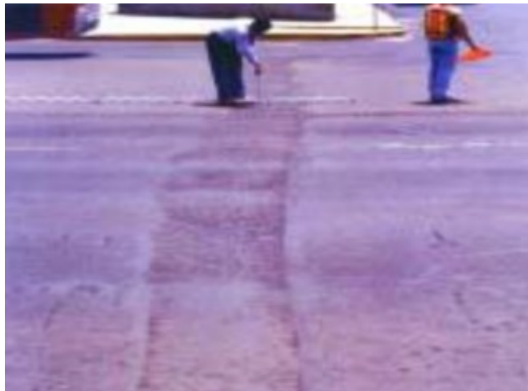
Figura 31: Asentamientos transversales (Barrera, 2014)
