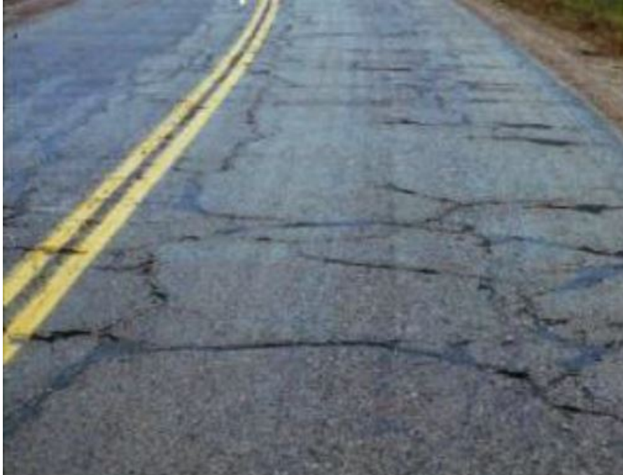
Figura 36: Fisura en bloque (Hernández, 2015)
