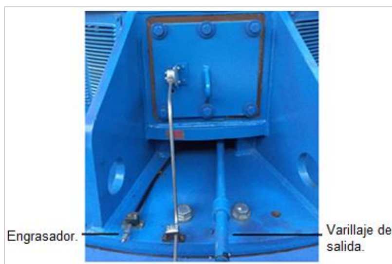
Figura 35. Lubricación de cojinete inferior a grasa del generador síncrono.
