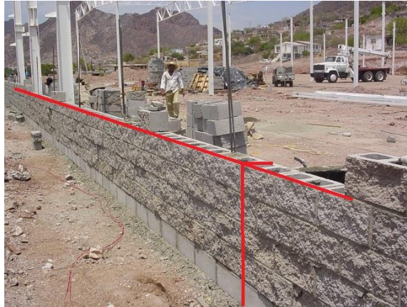
FOTOGRAFÍA 2. MURO DE BLOCK CON TEXTURA
