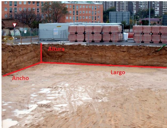
FOTOGRAFÍA 1. EXCAVACIÓN COMO MOVIMIENTO DE TIERRAS
