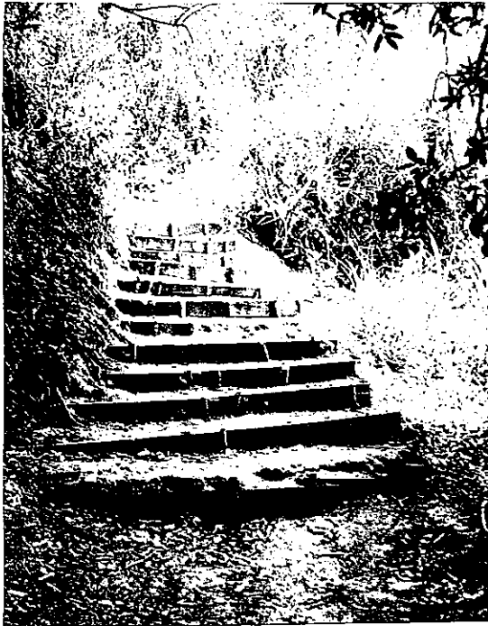
Figura 12. Construcción de gradas en un sendero interpretativo.
