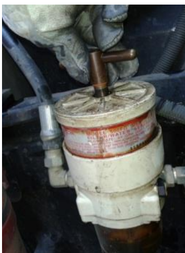
Figura 15: Grifo del depósito de filtro racor
