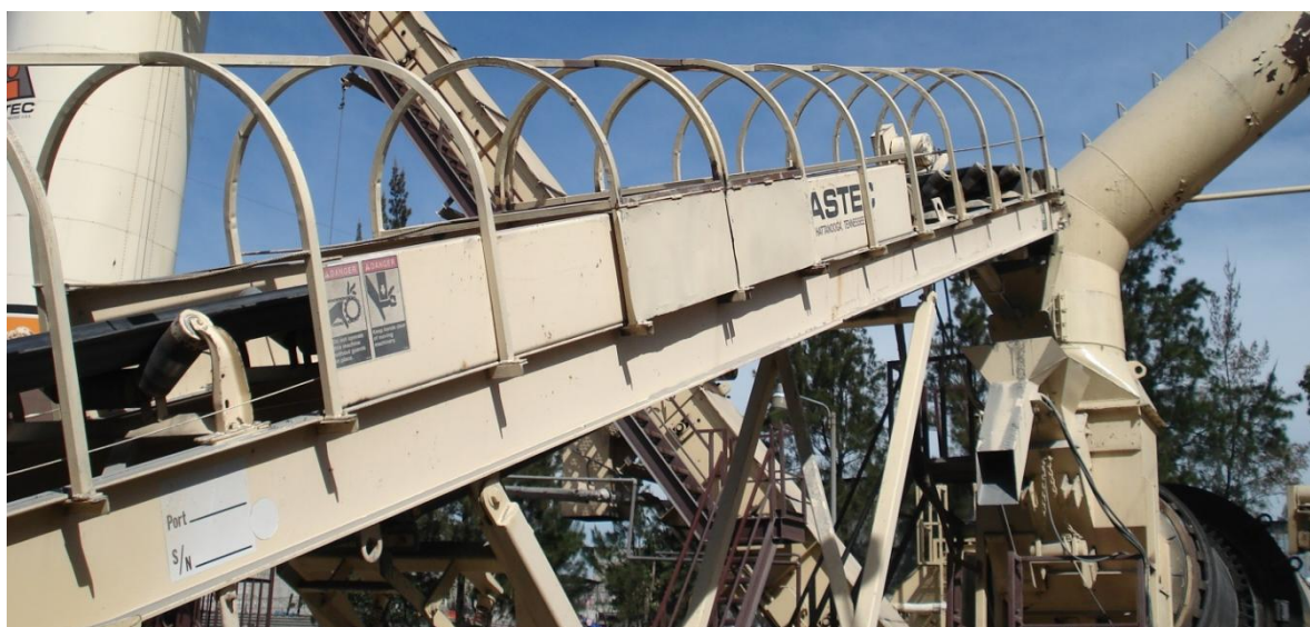
Ilustración 8. Banda de carga y báscula de puente. Planta de Padegua S.A.
