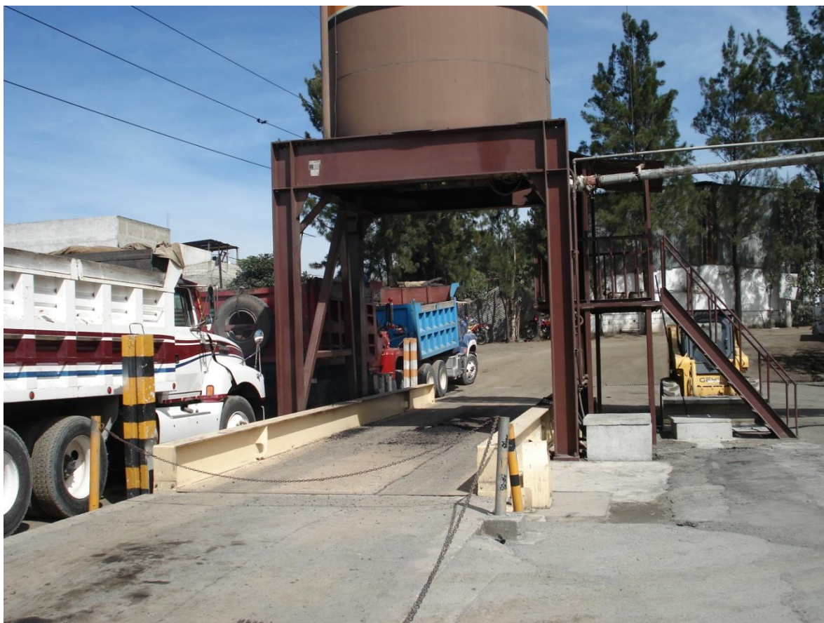
Ilustración 30. Zona de carga de camiones. Planta de Padegua, S.A.
