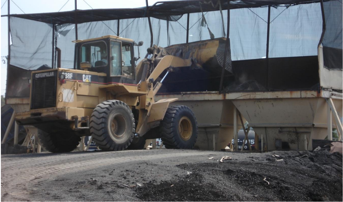
Ilustración 4. Carga de los tolvas de alimentación en frío.
