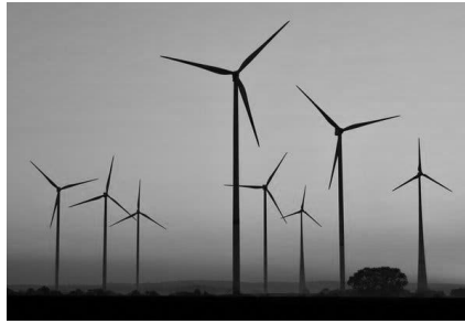
Ilustración 2 Turbina de viento
