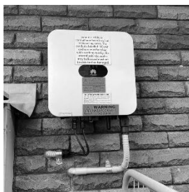
Ilustración 8 Inversor de red
