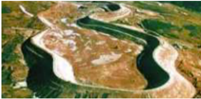
Figura No. 12 Hidroeléctrica de Aguayo
