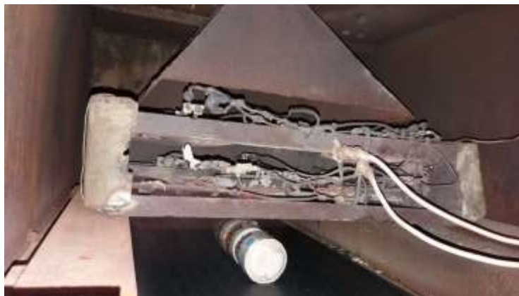
Ilustración 26. Interior del termo 3 de la planta
