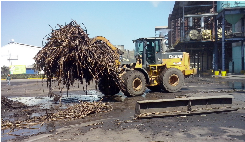
Figura No. 51: Acumulación de caña barrida a punto de ser reincorporada. Se puede observar el estancamiento de agua en la zona.
