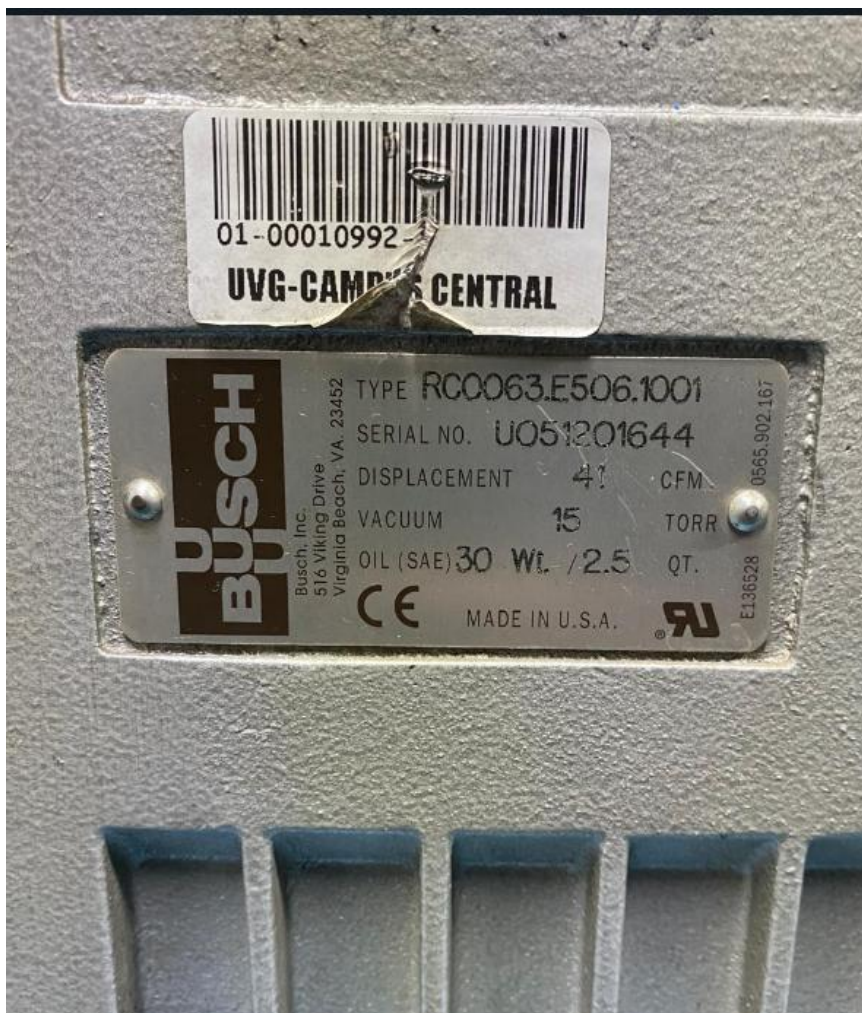
Figura 32. Datos de placa de la bomba de vacío
