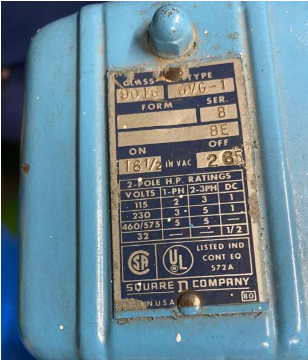
Figura 33. Datos de placa del regulador de la bomba de vacío
