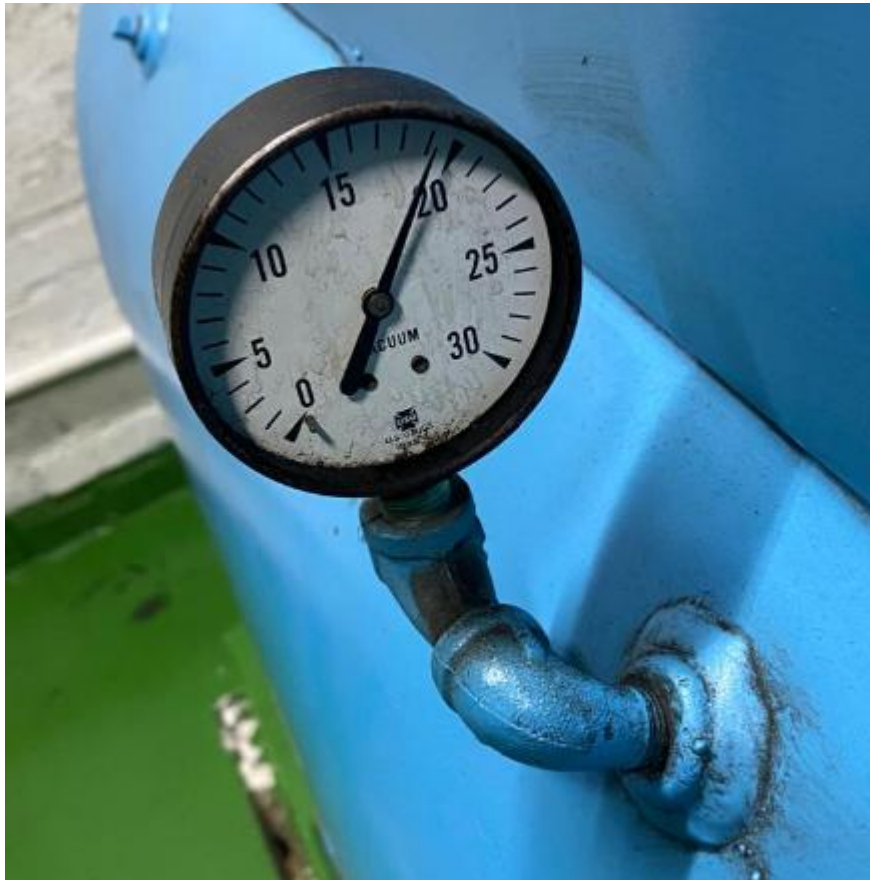
Figura 35. Presión de bomba de vacío de la Universidad del Valle de Guatemala
