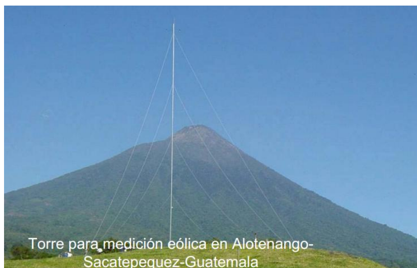
Ilustración 22: Torre de medición eólica en Guatemala.
