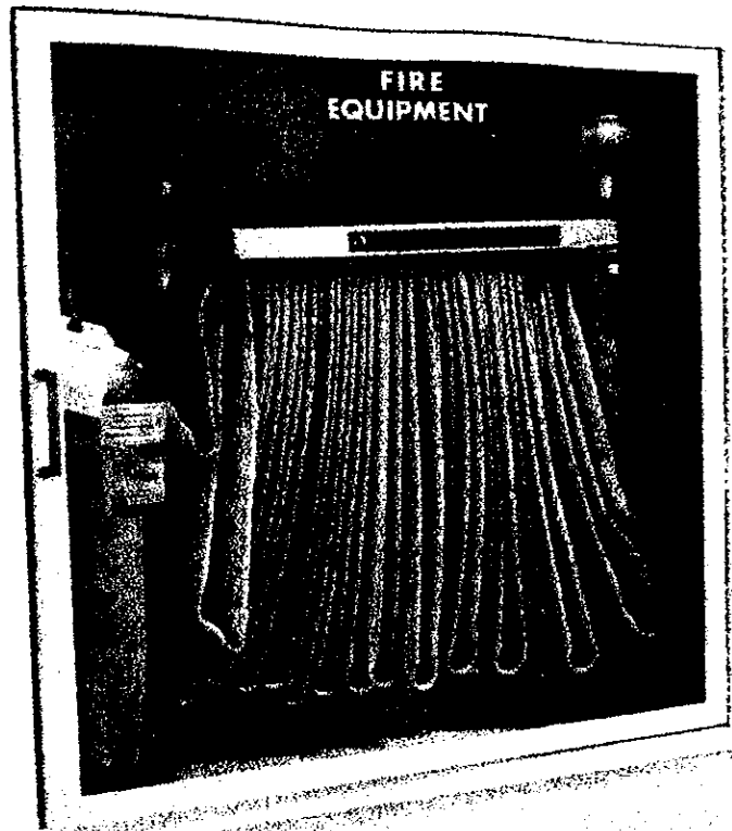
Típico gabinete contra incendios.
