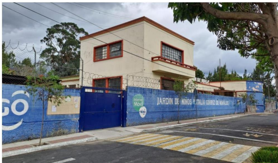
Fachada exterior de la escuela
