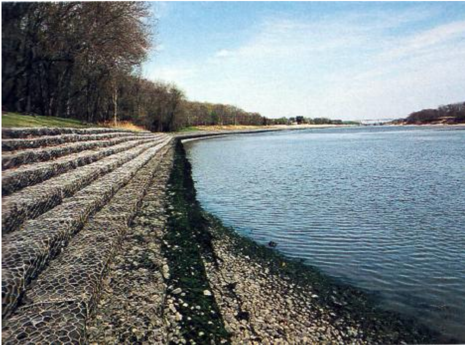
Figura 2.14 Muro lateral sobre el canal navegable Cape May, New Jersey, EEUU
