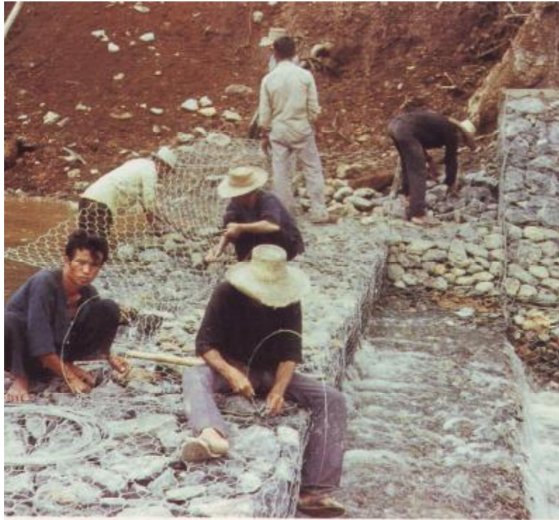
Figura 2.7 Personal armando gavión tipo caja
