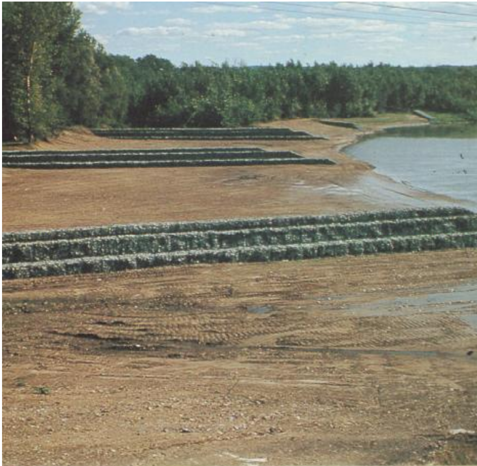
Figura 2.17 Espigones en Cattarungus Creek en Nueva York, EEUU
