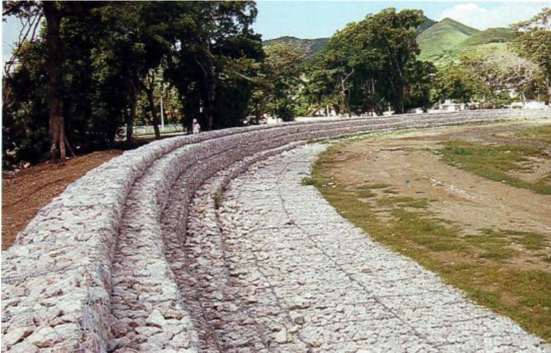
Figura 2.18 Protección realizada en Puerto Rico (1986)
