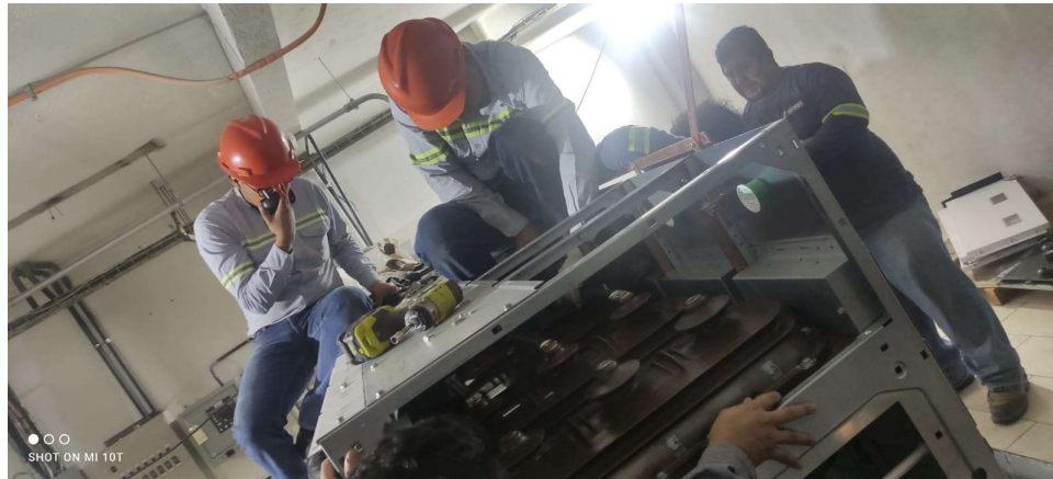
Figura 34. Trabajos de conexión entre celdas
