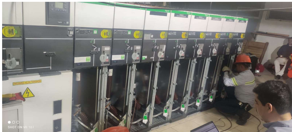
Figura 35. Instalación de fusibles en celdas de salida
