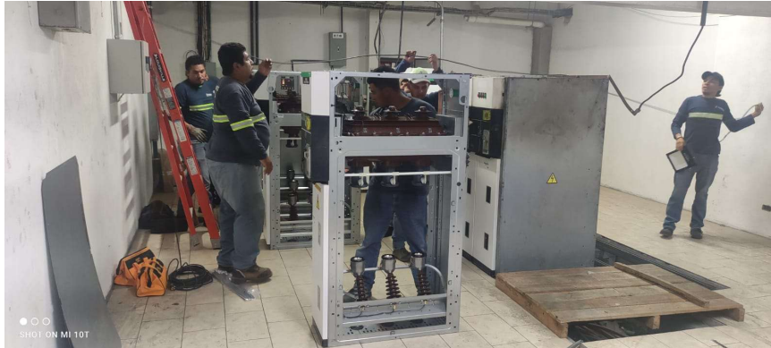
Figura 33. Inicio de trabajos de montaje de tren de celdas
