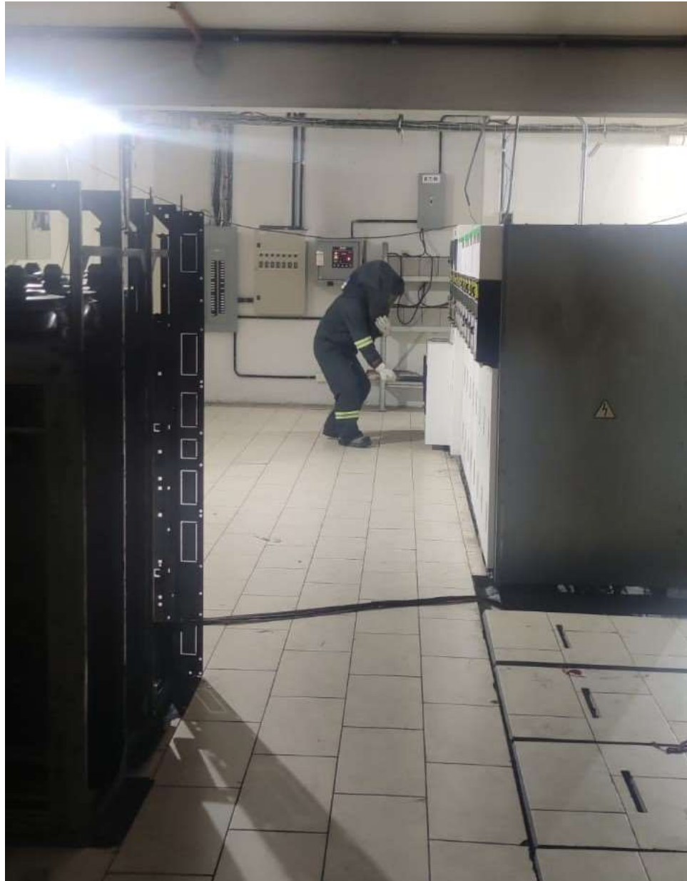
Figura 39. Energización de tren de celdas
