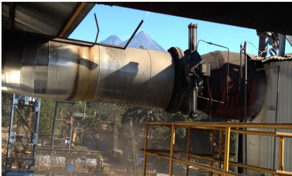
Figura 25: Aislamiento térmico de una tubería de vapor de un vaso evaporador.
