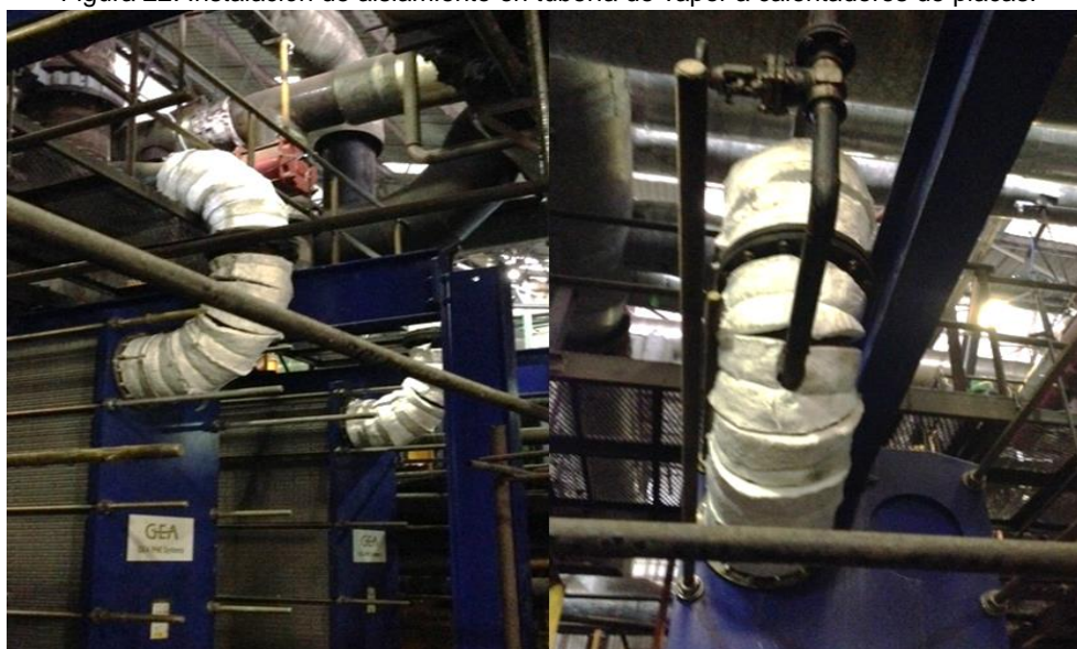
Figura 22: Instalación de aislamiento en tubería de vapor a calentadores de placas.
