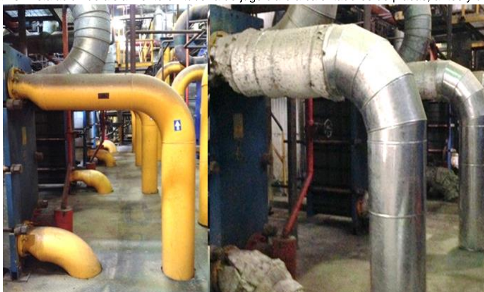
Figura 23: Instalación de aislamiento en tubería de jugo claro a calentadores de placas, antes y después.
