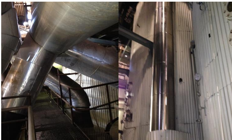
Figura 25: Aislamiento térmico de una tubería de vapor de un vaso evaporador.
