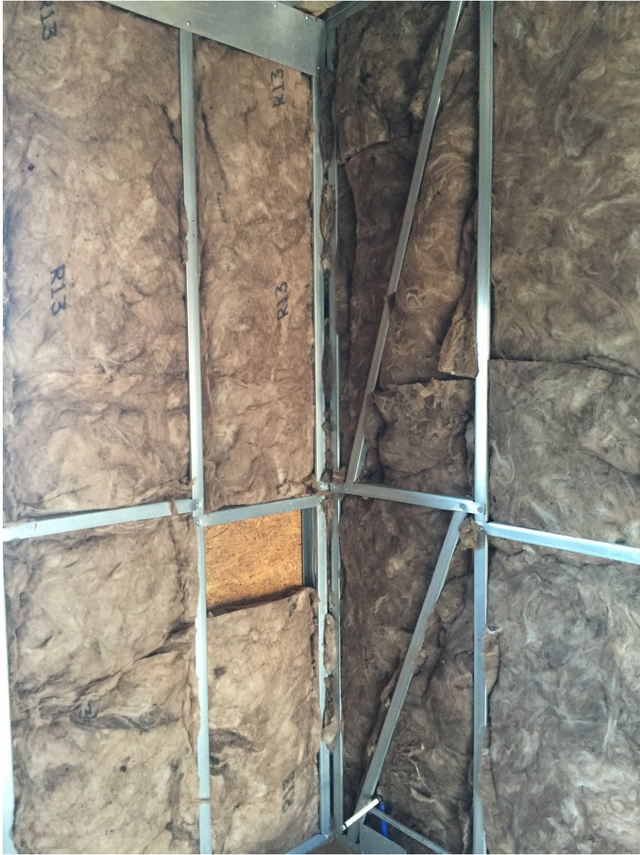
Figura 77: Colocación de fibra de vidrio en muros exteriores
