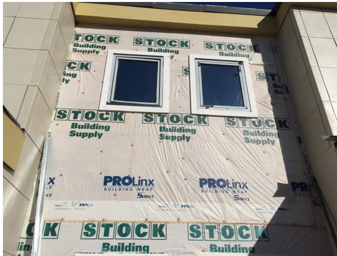
Figura 56: Impermeabilizante en plástico para el recubrimiento
