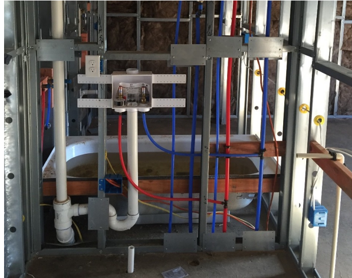
Figura 78: Instalación de tuberías hidráulicas y eléctricas en muros interiores
