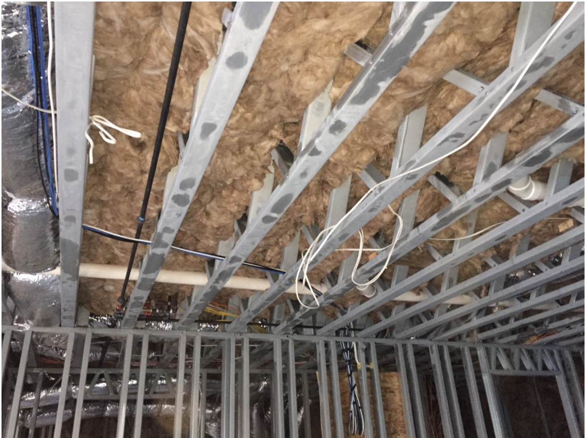
Figura 76: Colocación de fibra de vidrio en la losa de entepiso
