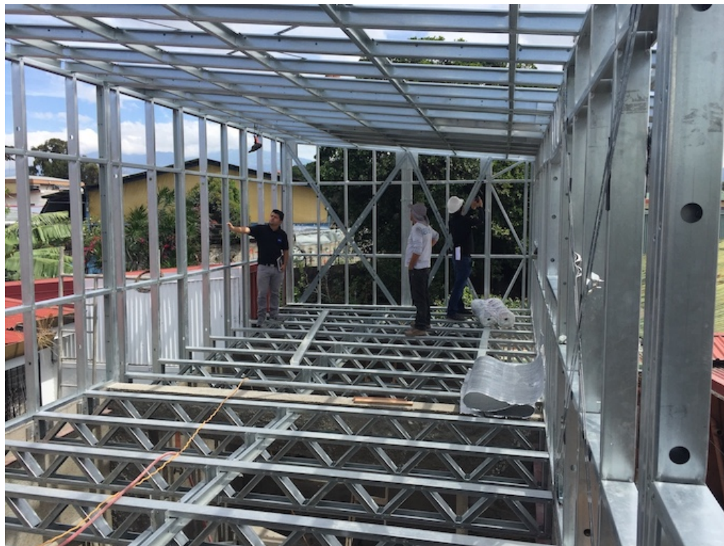
Figura 74: Instalación de los elementos estructurales de acero conformado en frío
