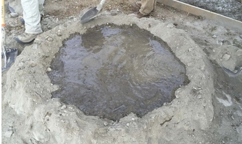
Figura 73: Creación del concreto premezclado para la union de los blocks
