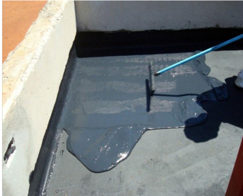
Figura 34: Aplicación del impermeabilizante en líquido [42]
