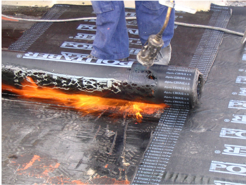
Figura 35: Aplicación del impermeabilizante asfáltico [42]
