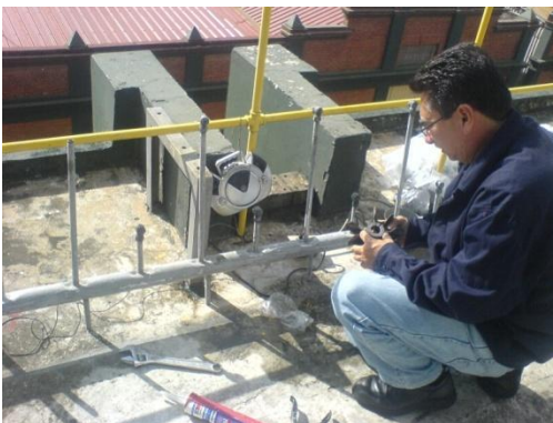
Ilustración No. 36. Limpieza de boquillas inyectadas
