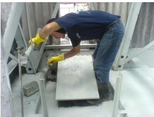
Ilustración No. 54. Pintura interior de la balsa
