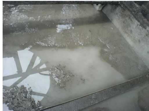
Ilustración No. 19. Balsa de agua fría con sedimentos
