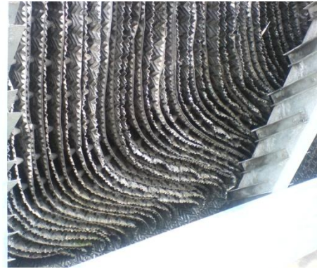
Ilustración No. 18. Relleno
