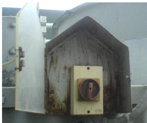
Ilustración No. 6. Interruptor
