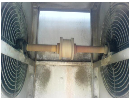
Ilustración No. 23. Corrosión en la estructura
