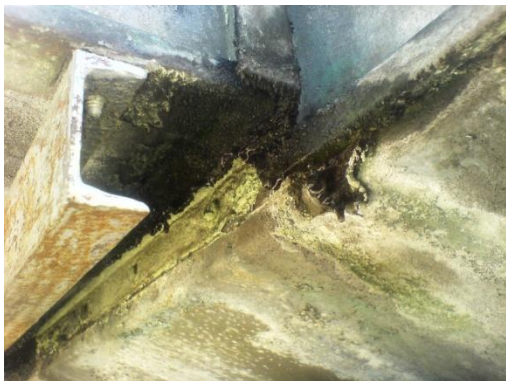
Ilustración No. 23. Corrosión en la estructura
