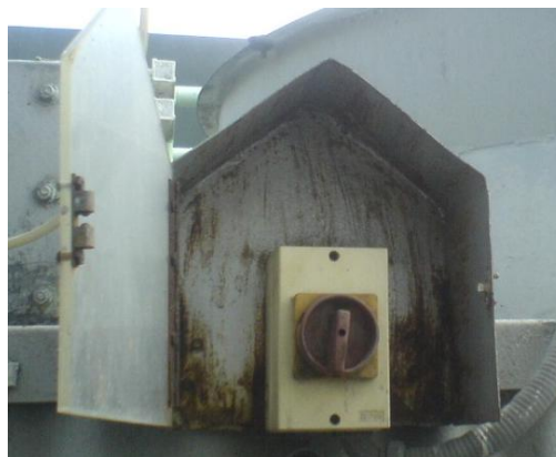
Ilustración No. 15. Interruptor
