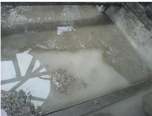
Ilustración No. 52. Balsa de agua fría
