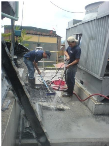
Ilustración No. 51. Lavado de las hojas
