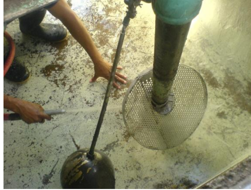
Ilustración No. 35. Colocación del filtro
