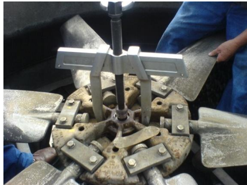
Ilustración No. 39. Extracción del ventilador
