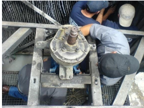
Ilustración No. 40. Desmontaje de la caja reductora
