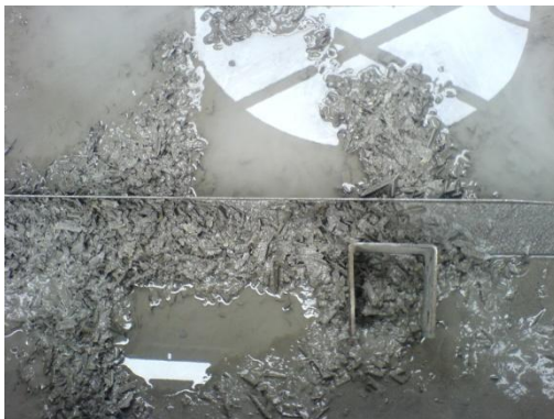
Ilustración No. 17. Balsa de agua fría con sedimentos
