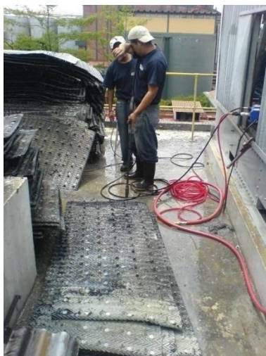
Ilustración No. 51. Lavado de las hojas
