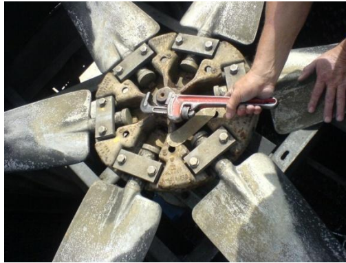
Ilustración No. 38. Remoción del perno central
