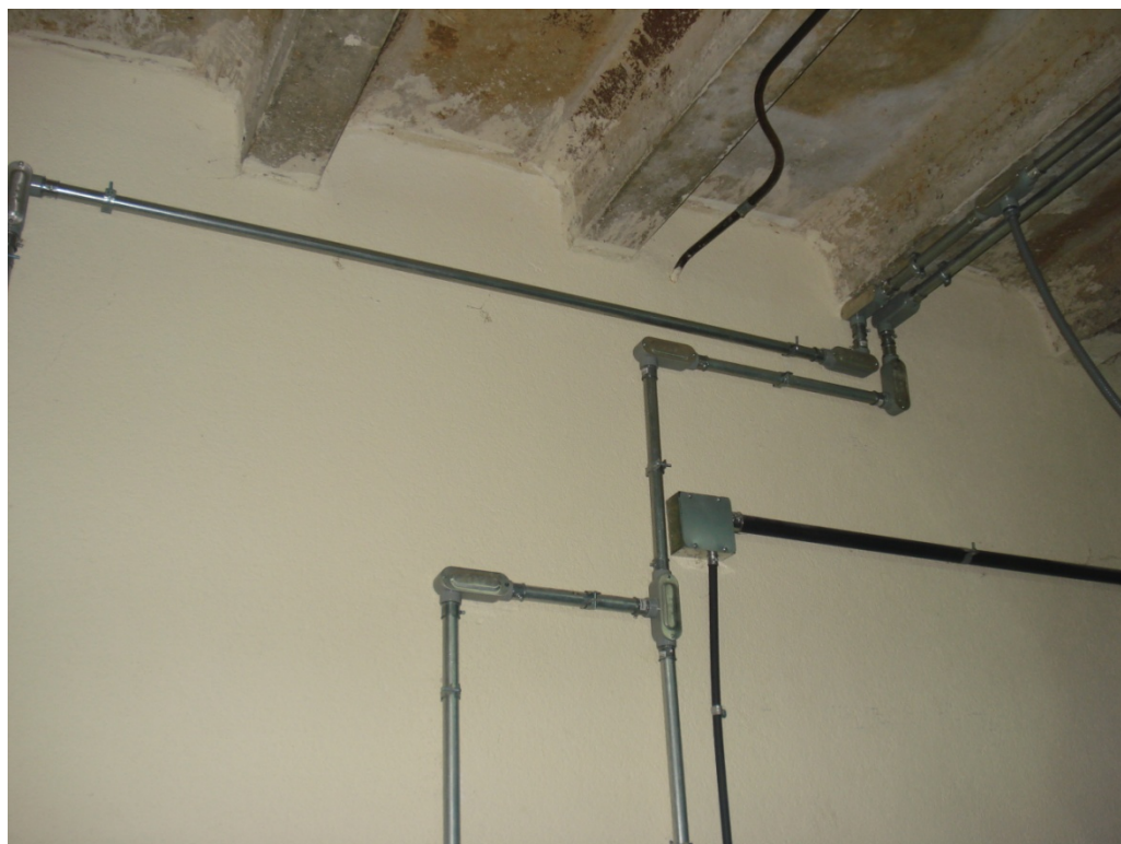
Figura 27. Imagen de tubería instalada.
