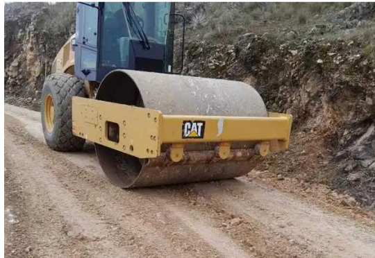
Figura 6. Ejemplo de estabilización mecánica – compactación de suelo Fuente: (Villar, 2023)
