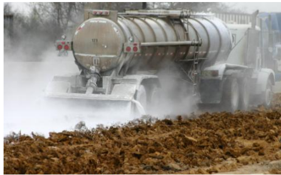
Figura 8. Ejemplo de estabilización química - Adición de conglomerante hidráulico Fuente: (Magalhaes, 2024)
