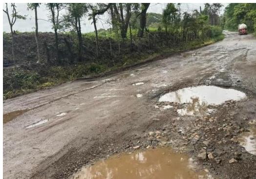
Figura 24. Camino rural con formación de baches Fuente: (Cardona, 2012)
