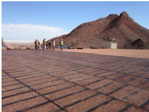
Figura 7. Ejemplo de estabilización física -colocación de geomallas Fuente: (ECOMEX, 2024)
