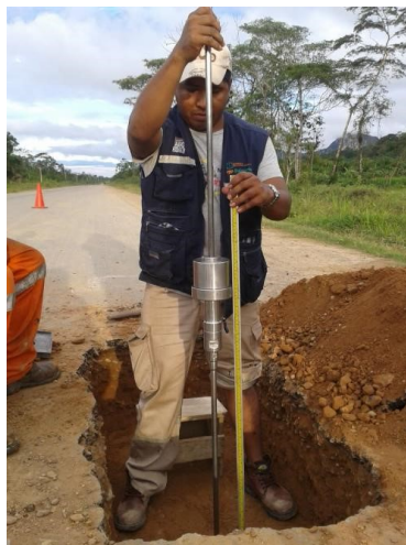
Figura 28: Excavación de calicata en pavimento flexible (Mecanicista, s.f.)
