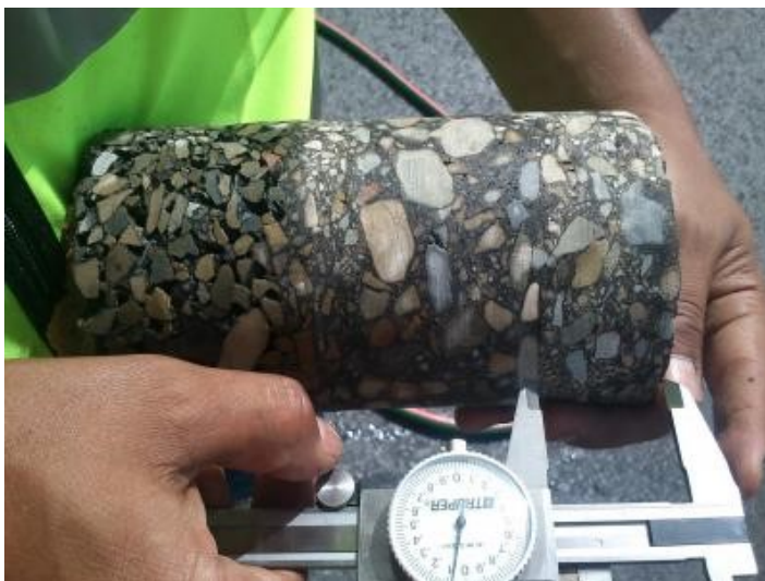
Figura 29: Núcleo o testigo extraído de una carpeta asfáltica (Mecanicista, s.f.)
