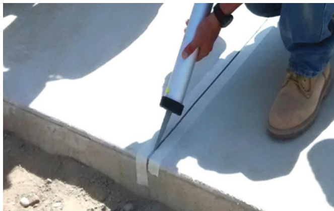
Figura 42: Sellado de juntas (Probacons S.A., s.f.)
