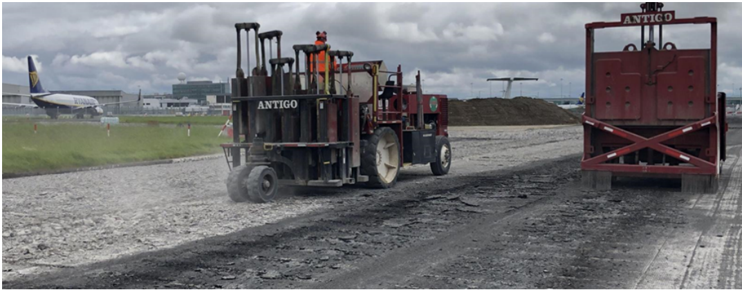
Figura 38: Rubblizado de concreto hidráulico (Antigo, s.f.)
