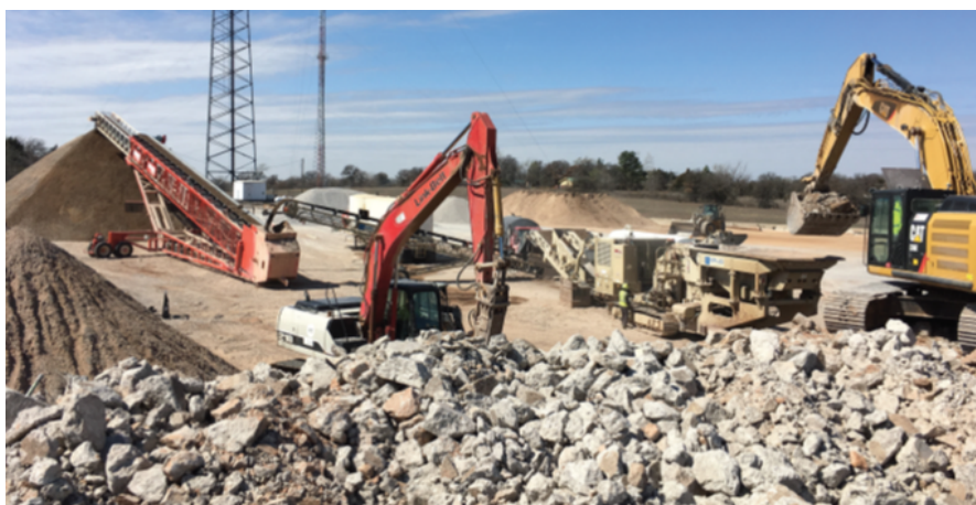
Figura 36: Operación de reciclado y apilado del reciclado de hormigón (Snyder, 2018)
