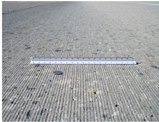
Figura 41: Textura de la superficie después del triturado de concreto (FHWA, s.f.)
