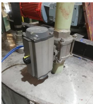
Ilustración 8 - Actuador neumático
