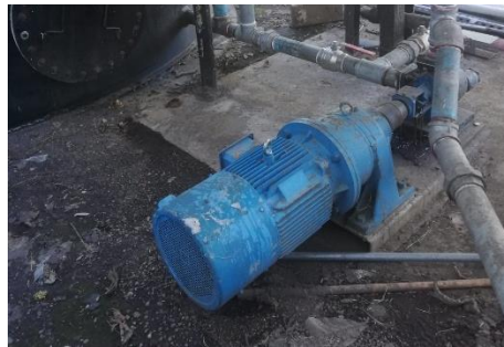
Ilustración 6 - Bomba hidráulica
