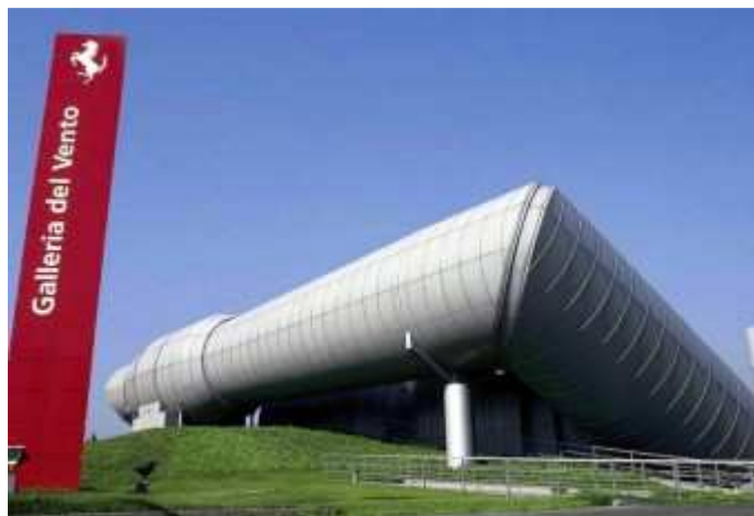
Figura 1. Túnel de Viento Maranello de Ferrari
