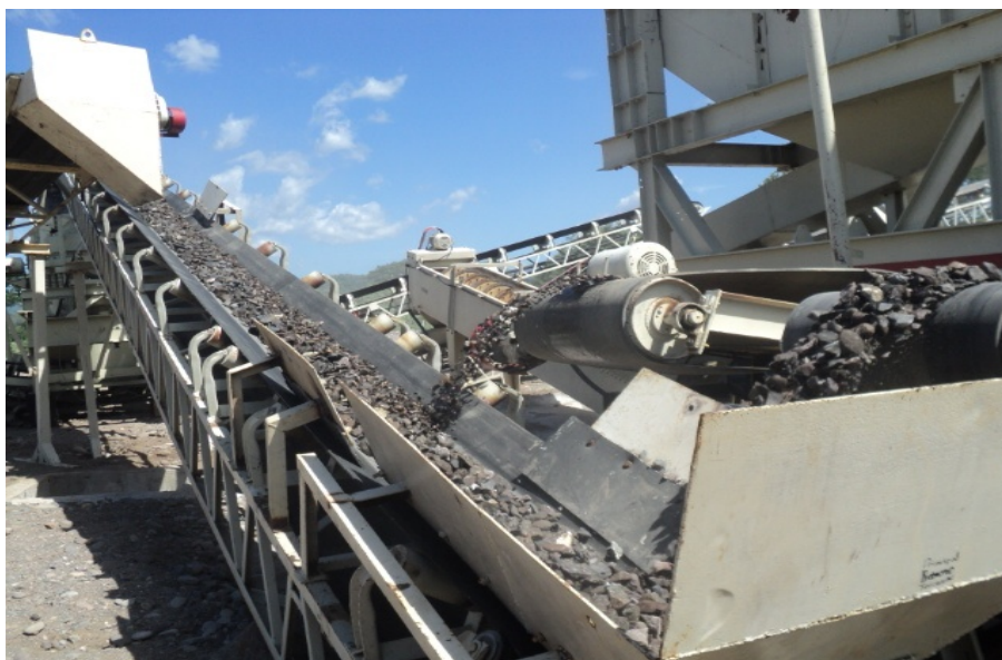
Ilustración 20. Transporte de material mediante cintas transportadoras entre etapas de trituración.
