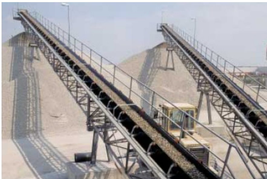
Ilustración 21. Disposición final de agregados mediante cintas transportadoras
