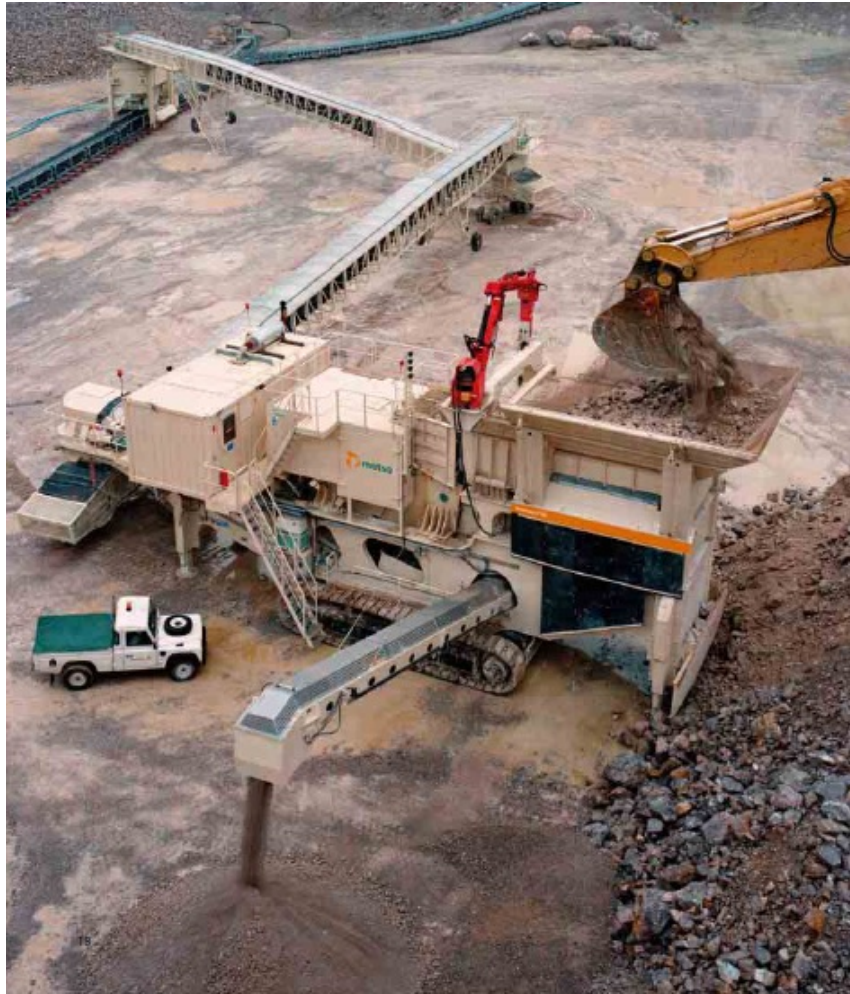
Ilustración 7. Planta móvil de trituración montada sobre orugas
