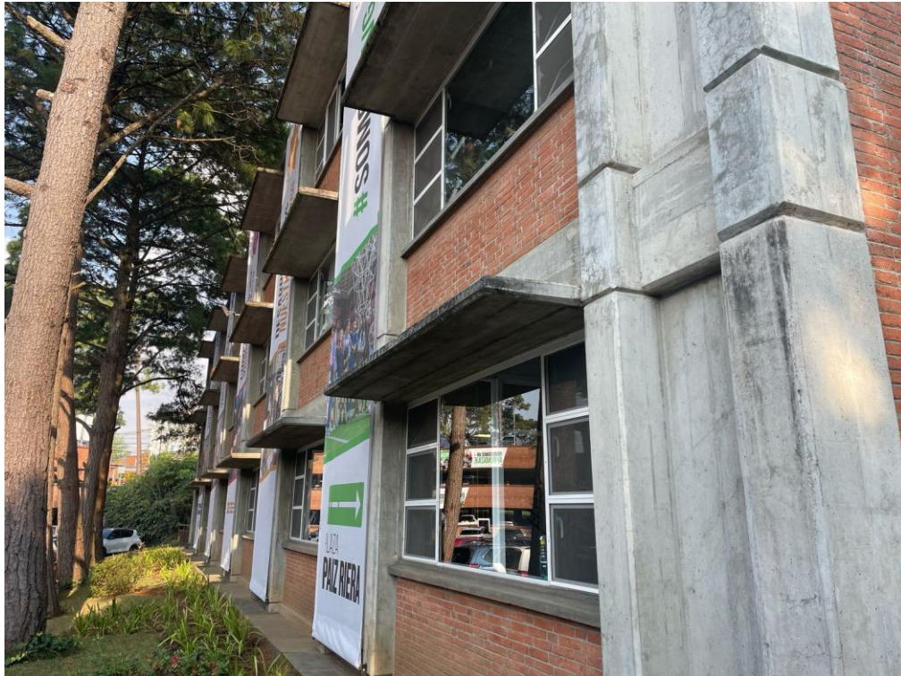
Figura 12. Voladizos sobre ventanas en fachada norte Edificio A en Universidad del Valle de Guatemala, Campus Central
