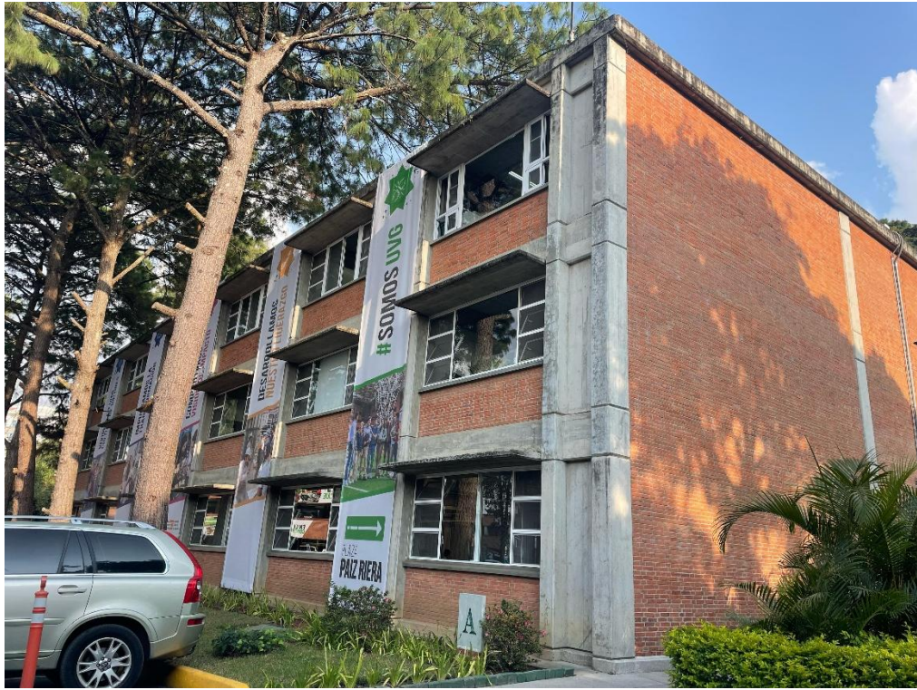
Figura 8. Fachada norte Edificio A en Universidad del Valle de Guatemala, Campus Central
