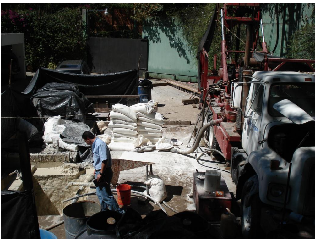
Imagen 28. Zona de perforación.
