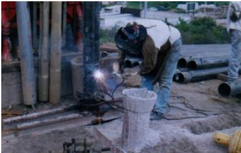
Imagen 9. Entubado de un pozo.
