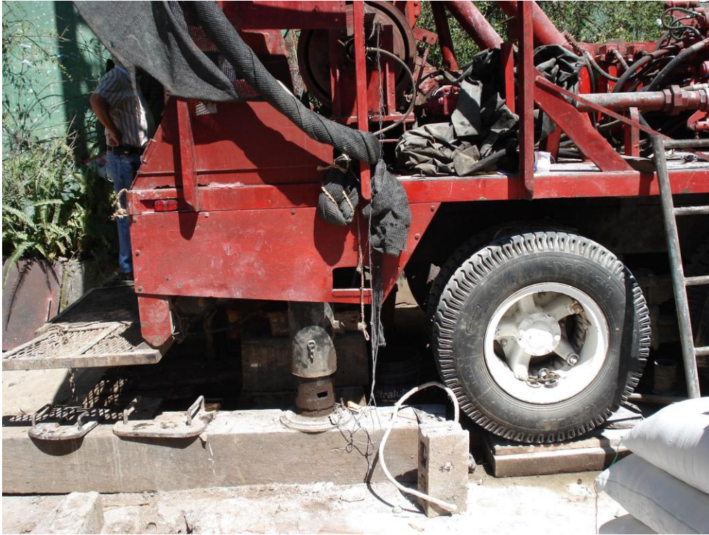
Imagen 26. Nivelación de maquinaria.
