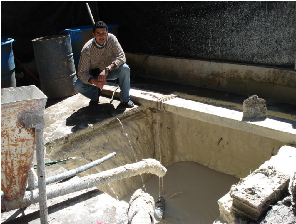
Imagen 31. Pila de preparación de lodos.
