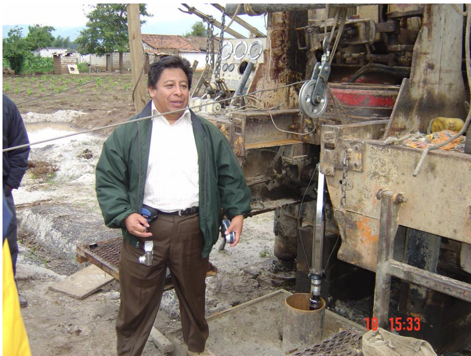
Imagen 6: El ejecutor presenciando la prueba de verticalidad del pozo X.
