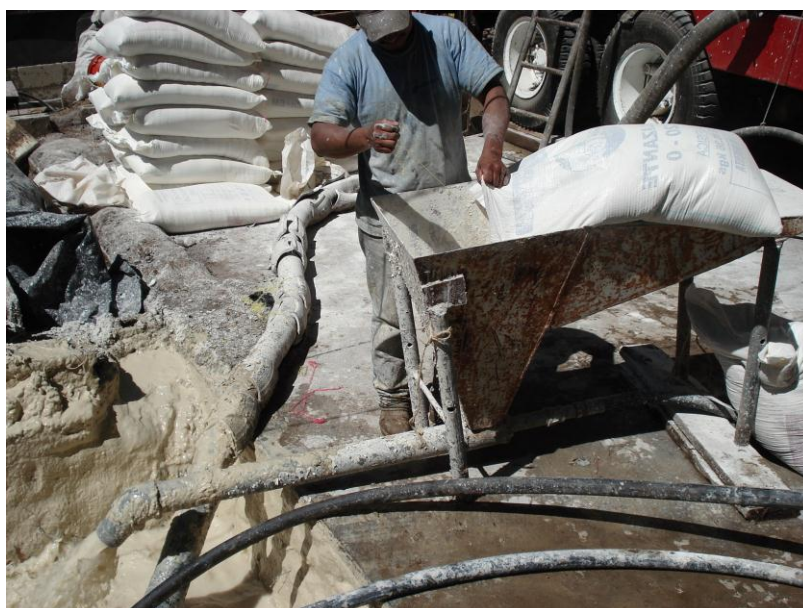
Imagen 29. Preparación de bentonita.
