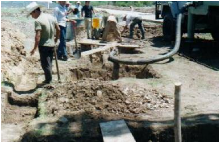
Imagen 32. Preparación de pila para lodos.
