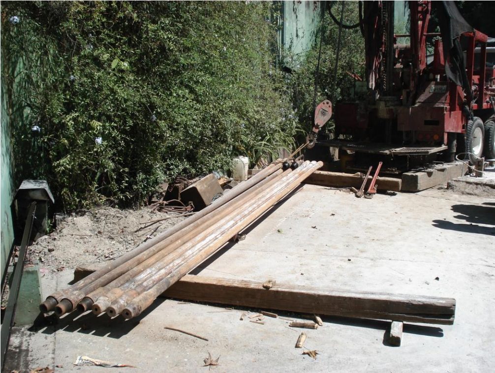
Imagen 18. Tubería de perforación.
