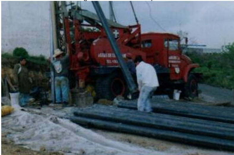
Imagen 8. Entubado de un pozo.
