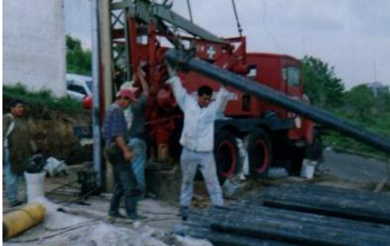
Imagen 7. Entubado de un pozo.
