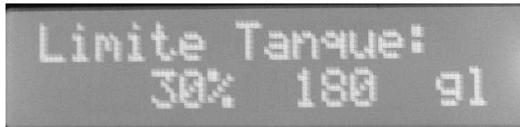
Figura 50. Límite de cisterna indicado por usuario en panel central y desplegado en LCD.
