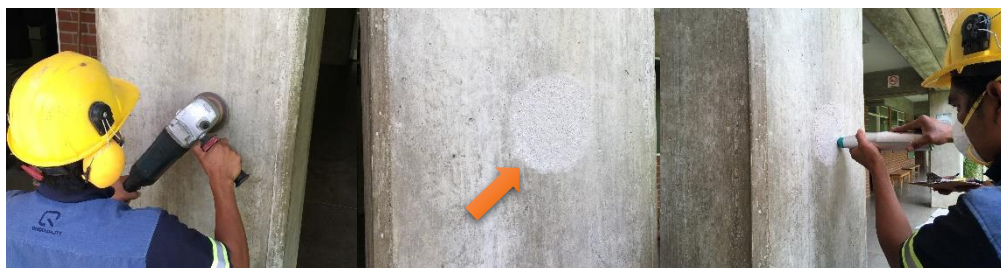
Ilustración 19 – Ensayo de martillo en concreto endurecido en la Universidad del Valle
