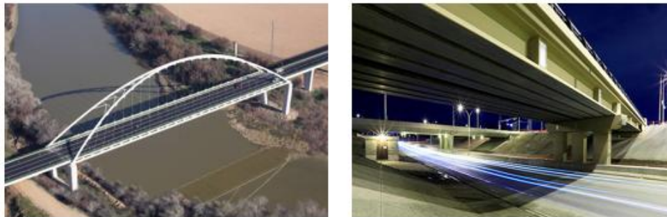
Figura 1- Ejemplos de puentes según el tipo de obstáculo que se desea atravesar.
