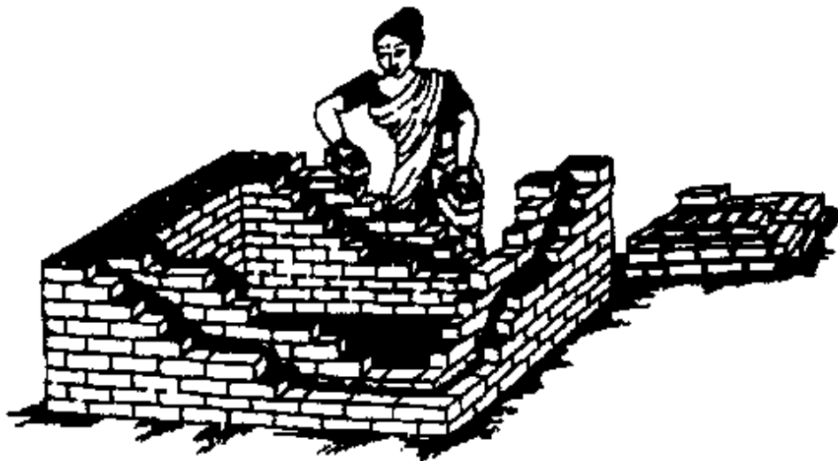
Figura No. 103. Construcción del ZECC en el cual se construye con dos paredes de ladrillos y entre cada pared una cavidad que contiene arena
