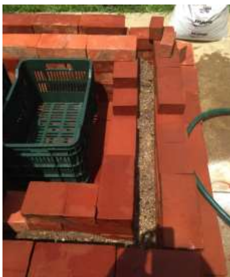
Figura No. 94: Construcción de ZECC
