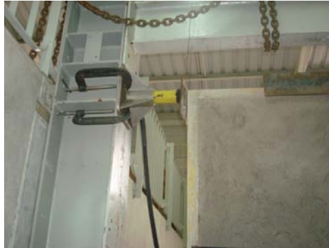
Figura 43: Punto de aplicación de la carga lateral a los paneles utilizando un gato hidráulico con capacidad de 10 toneladas.
