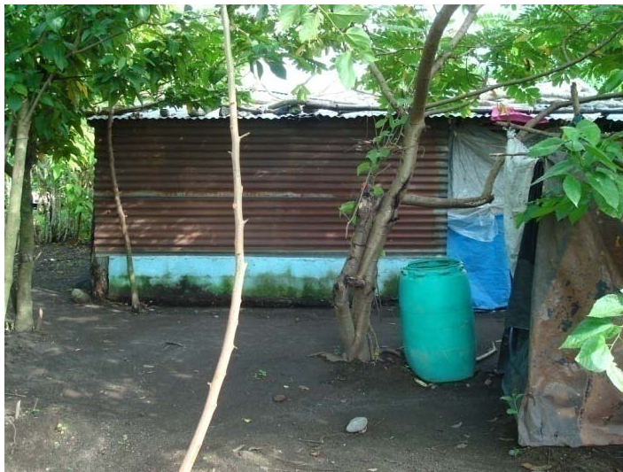
Figura 87: Construcción informal de la vivienda actual.
