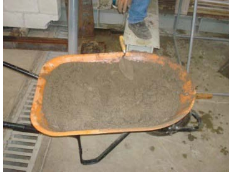
Figura 14: Mortero preparado para el repello
