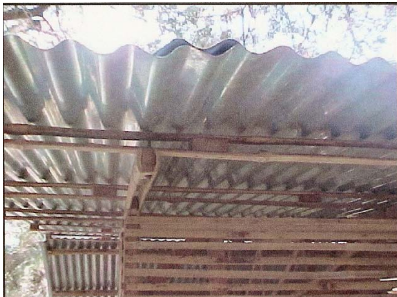
Figura 32: Detalle de costaneras y lámina (13)
