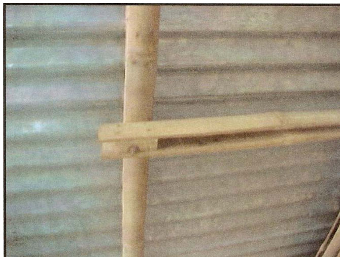
Figura 31: Detalle de la armadura de techo (13)
