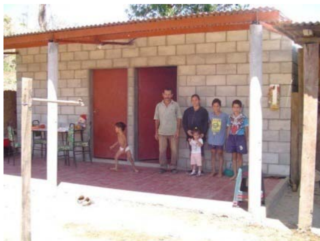
Figura 94: Vivienda de mampostería
