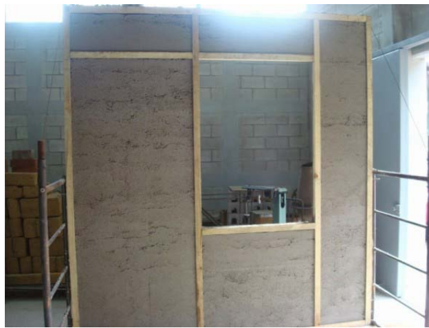
Figura 23: Panel de madera con esterilla de bambú repellado
