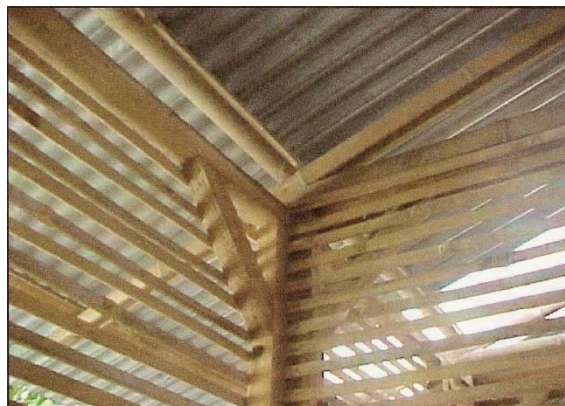
Figura 29: Juntas de unión esquinas superiores (13)
