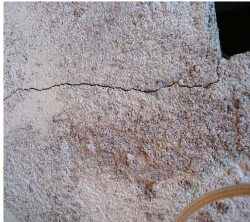
Figura 7: Grietas superficiales.
