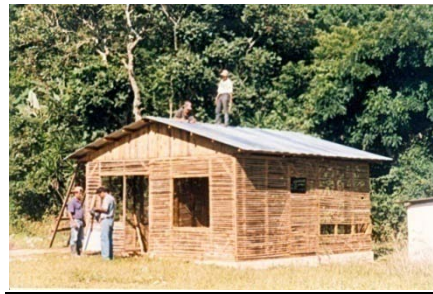
Figura 96: Construcción de vivienda de bambú
