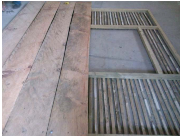
Figura 34: Panel armado con formaleta
