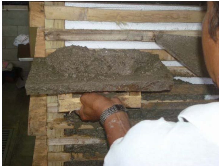
Figura 37: Panel totalmente repellado
