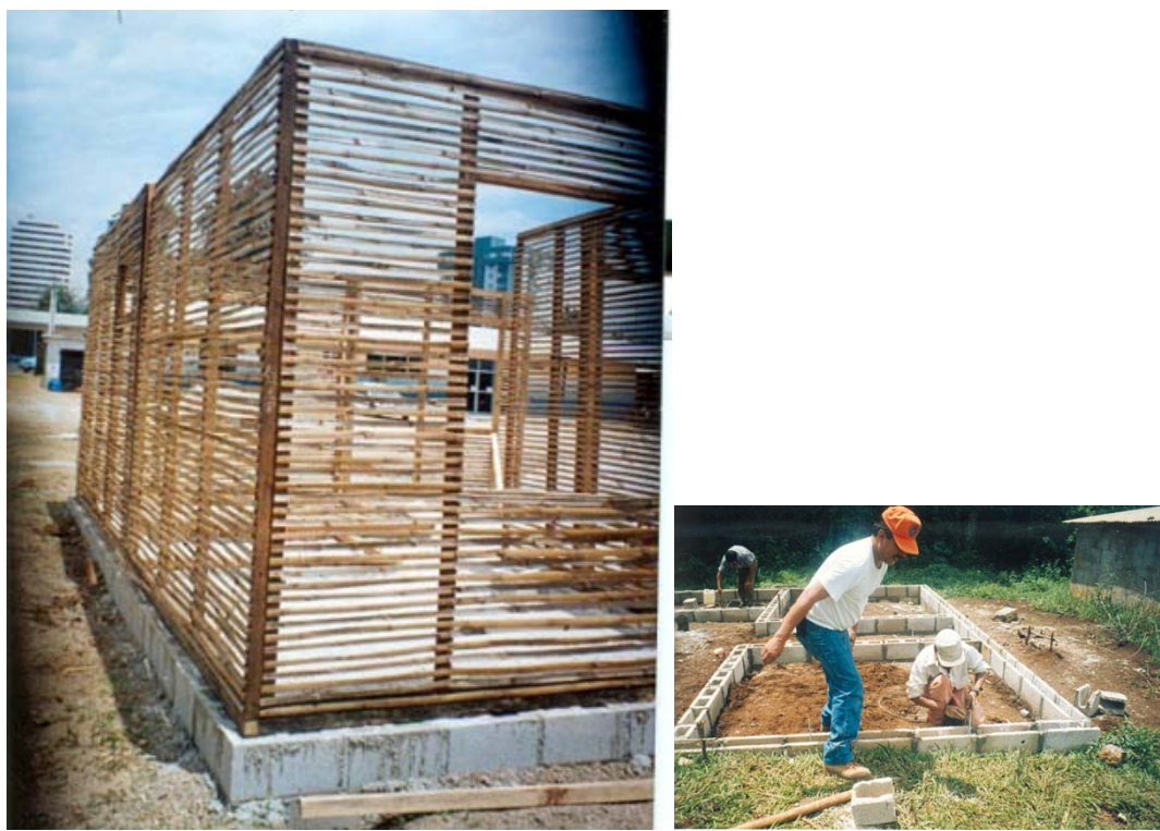
Figura 97: Construcción de vivienda en la SE-CONRED
