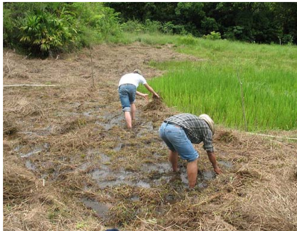
Figura 19: Limpieza del terreno.
