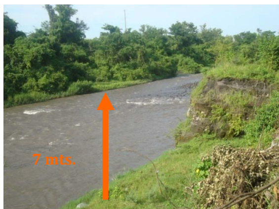
Figura 86: Vista de la topografía irregular de la orilla del cauce del río Pantaleón al plano de la vivienda evaluada.
