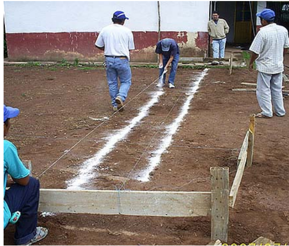
Figura 20: Trazo del terreno para cimentación
