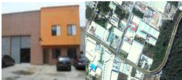
Figura no. 8 Bodega en zona franca El Naranjo
