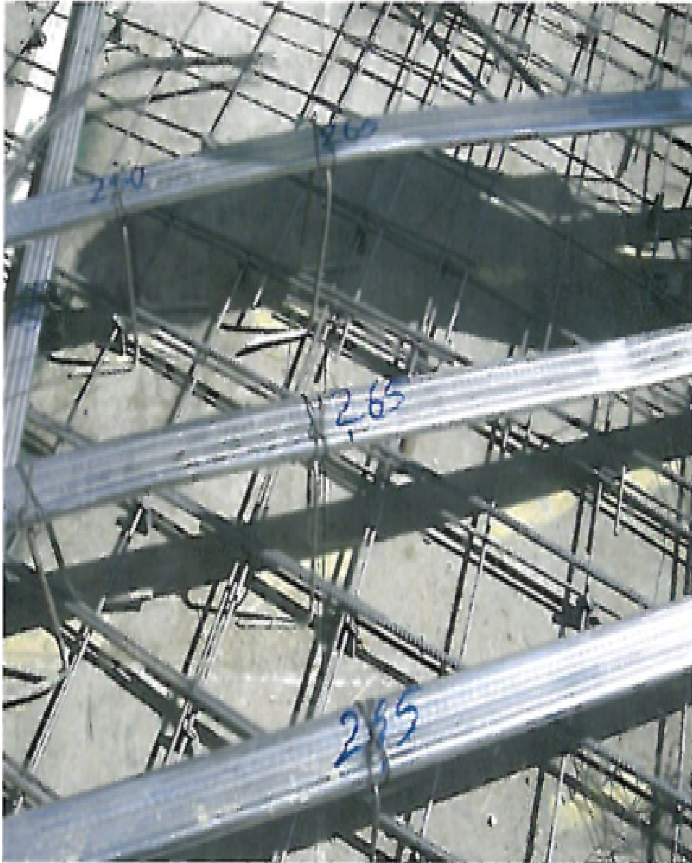
Figura No. 59. Marca de altura requerida en punto específico del tendón
