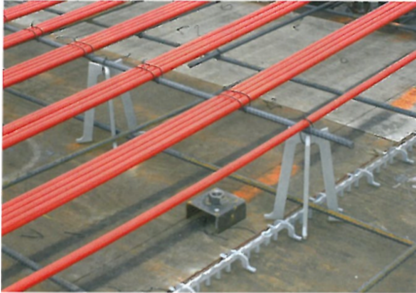
Figura No. 56. Metodología usada para asegurar tendones en posición y altura.
