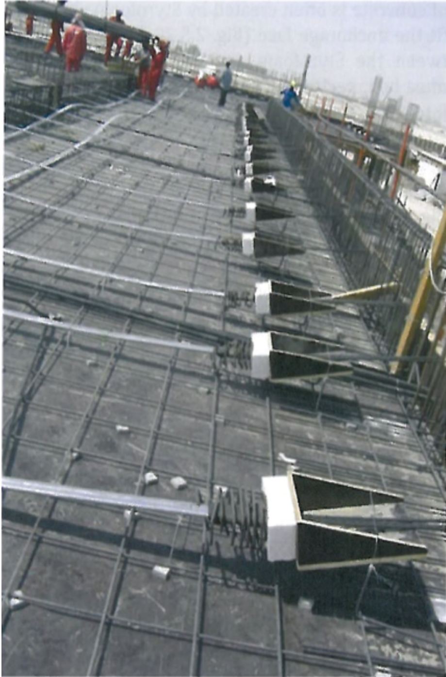
Figura No. 58. Fila de anclajes activos cercanos a muros
