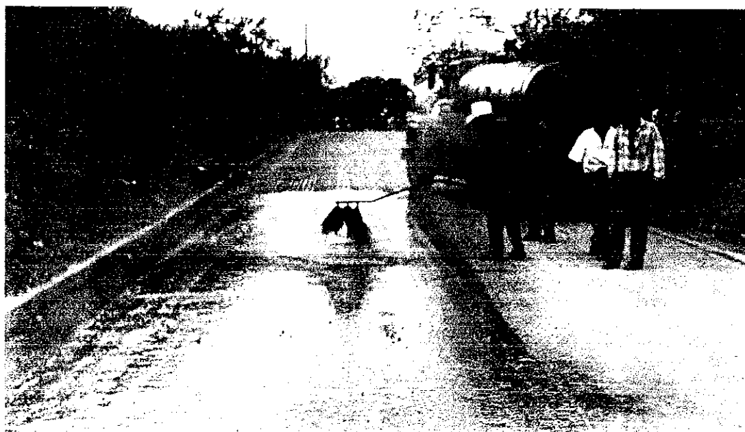
Figura 5.6: Correcciones del riego de asfalto
