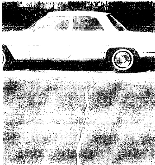
Figura 6.2: Grieta transversal
