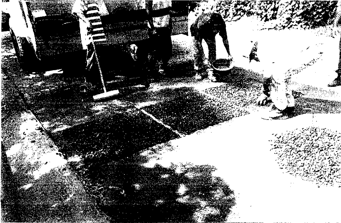
Figura 4.11: Calibración y chequeo del punto de riego de la esparcidora
