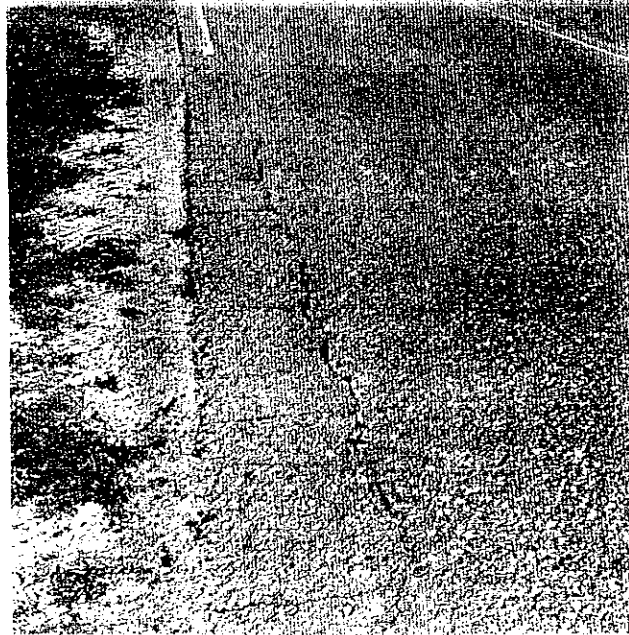
Figura 6.3: Grieta longitudinal
