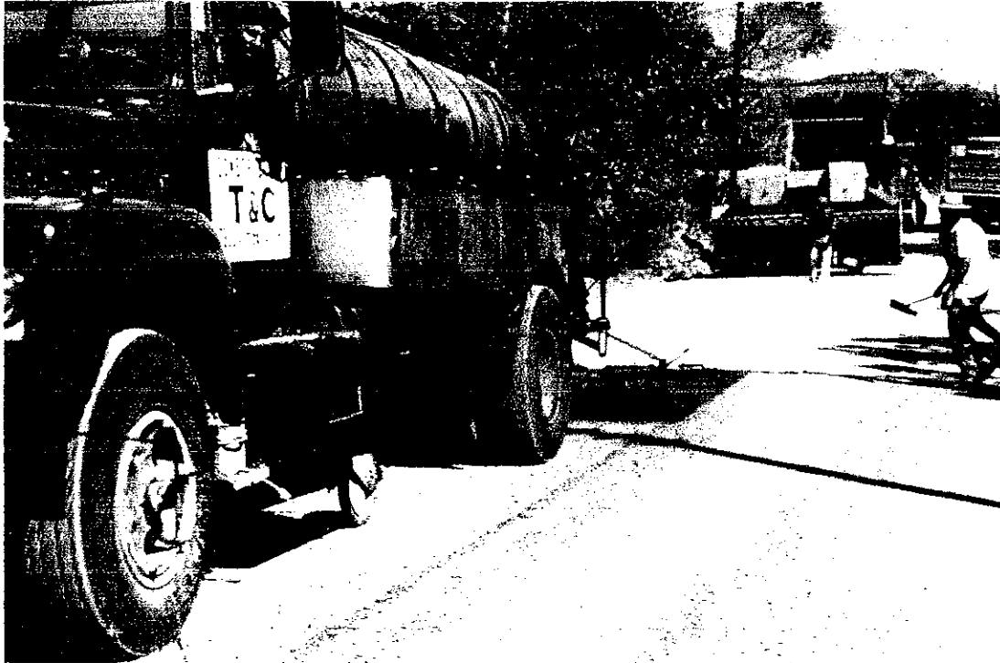
Figura 5.3: Riego de asfalto
