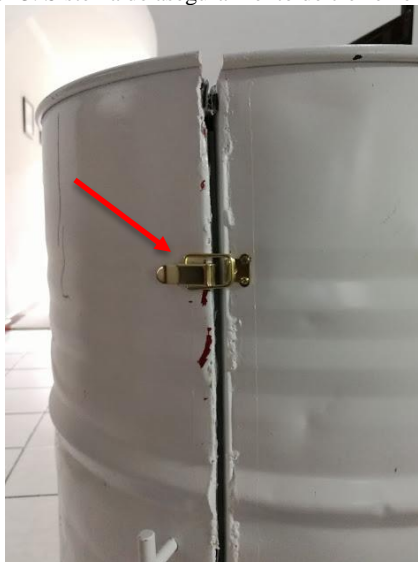
Figura 23. Sistema de aseguramiento de cierre hermético.
