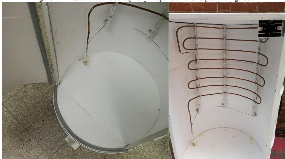
Figura 27. Instalación del tubo capilar y evaporador en el espacio refrigerado.
