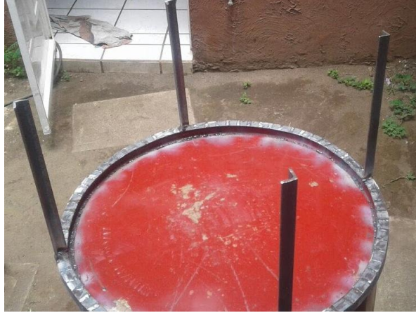
Figura 20. Soldadura de los soportes.
