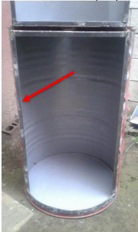
Figura 17. Soldadura de hembra en los marcos de la puerta y de la base del refrigerador.
