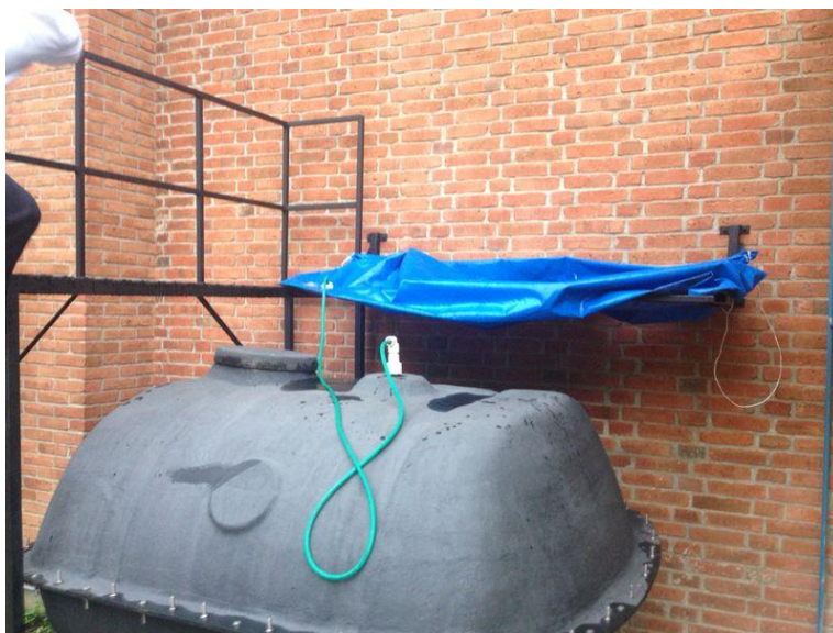
Ilustración 26: "Biodigestor piloto semana 1 en carga de residuos sólidos provenientes del Zoológico "La Aurora"
