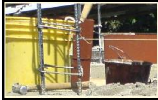
Ilustración 56. Herramientas utilizadas para construcción de muro.
