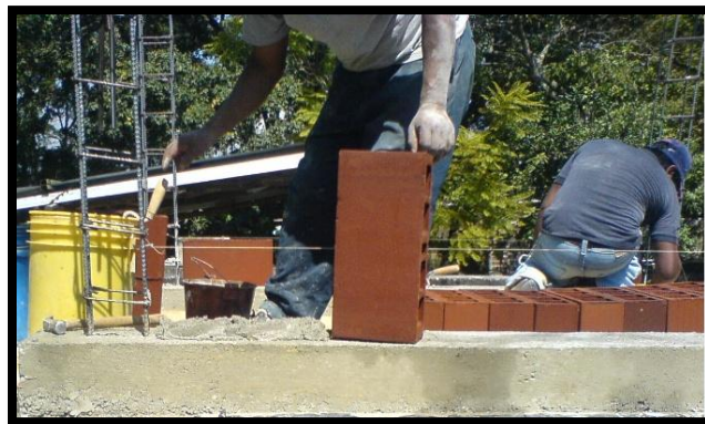
Ilustración 58. Proceso de construcción de muro.
