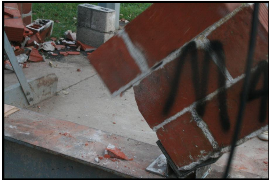
Ilustración 89. Prisma ensayado M4 (Falla por adherencia).
