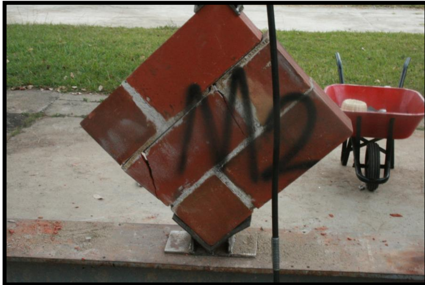
Ilustración 87. Prisma ensayado M2 (Falla semi-diagonal).
