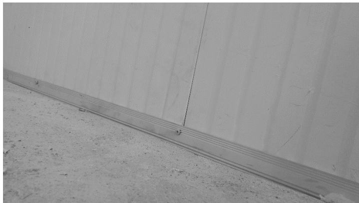
Figura 56. Sujeción de panel a perfil interior (angular anclado al suelo) con tornillo de \frac{3}{4} de pulgada
