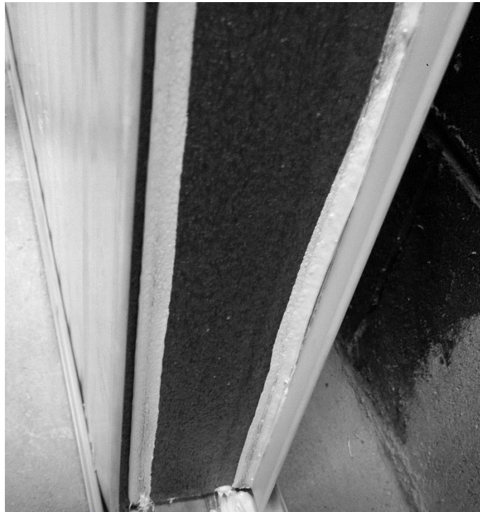
Figura 54. Sello de butilo en unión de panel
