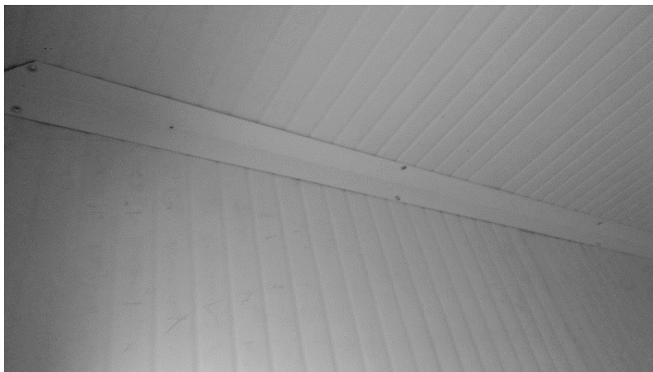
Figura 57. Fijación de perfil interior al panel con tornillo de \frac{3}{4} de pulgada
