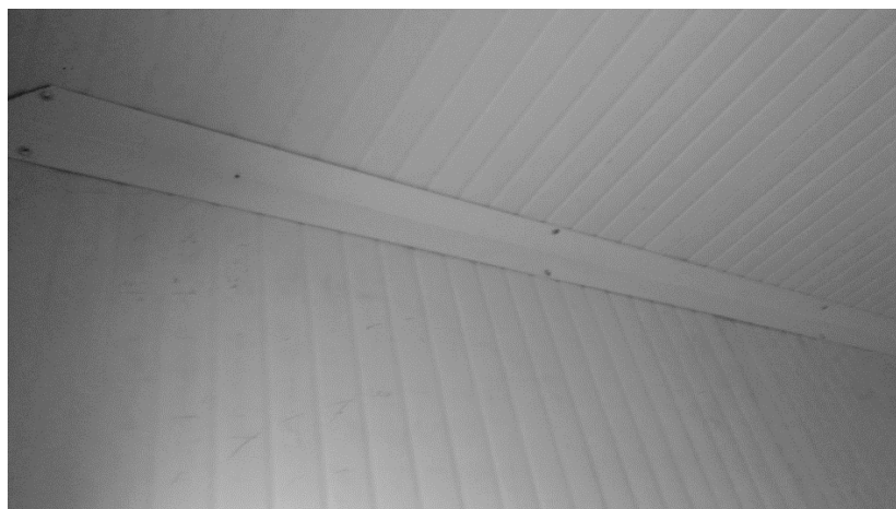
Figura 43. Detalle de perfil interior con fijaciones
