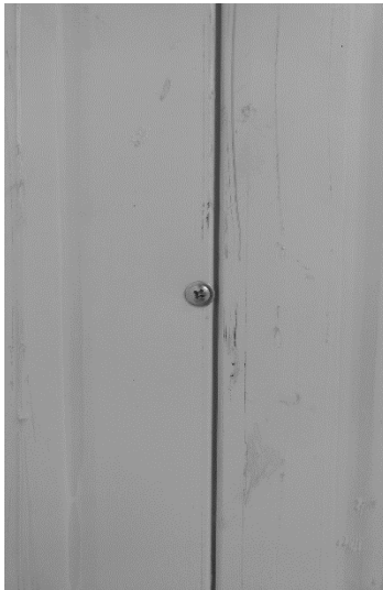
Figura 55. Sujeción de panel mediante tornillo de \frac{3}{4} de pulgada
