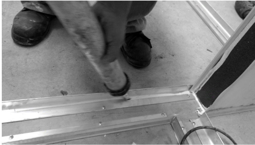
Figura 45. Montaje de panel al suelo con angulares
